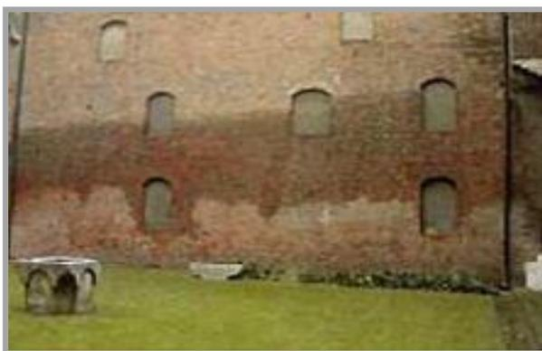
**Fronte di risalita:** Limite di migrazione dell'acqua che si manifesta con la formazione di efflorescenze e/o perdita di materiale. E' generalmente accompagnato da variazioni della saturazione del colore nella zona sottostante;
