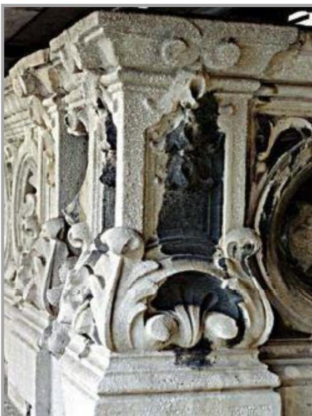
**Crosta:** Modificazione dello strato superficiale del materiale lapideo. Di spessore variabile, generalmente dura, la crosta è distinguibile dalle parti sottostanti per le caratteristiche morfologiche e spesso per il colore. Può distaccarsi anche spontaneamente dal substrato che, in genere, si presenta disgregato e/o polverulento;
