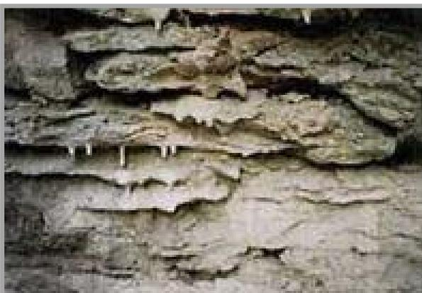
**Incrostazione:** Deposito stratiforme compatto e generalmente aderente al substrato. Si definisce concrezione
