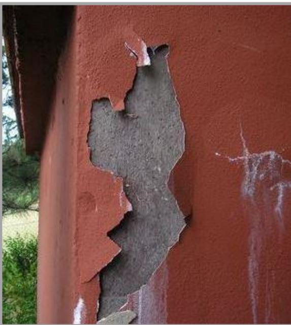
cristallizzazione. Il fenomeno, a differenza di quanto accade con le efflorescenze, avviene all'interno della muratura poiché il solvente evapora prima che i sali raggiungano la superficie esterna. Se dunque il problema generato dalle efflorescenze è principalmente di natura estetica, quello prodotto dalle subfiorescenze risulta di natura strutturale e per tanto molto più pericoloso. I sali che erano contenuti nella soluzione, perso il loro solvente,
