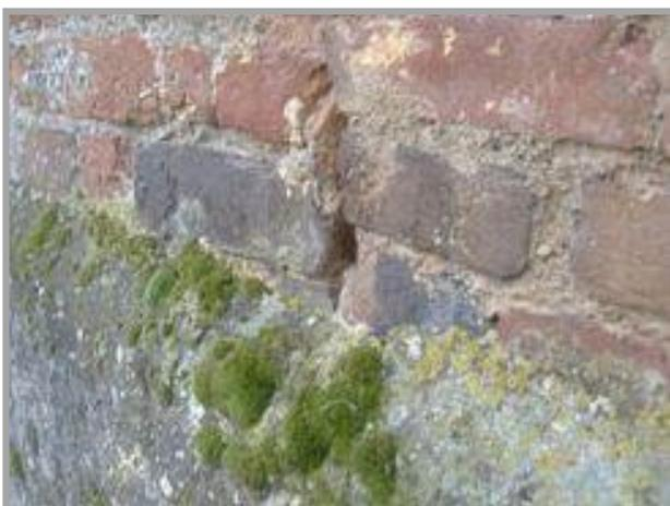
**Patina biologica :** Strato sottile ed omogeneo, costituito prevalentemente da microrganismi, variabile per consistenza, colore e adesione al substrato;
