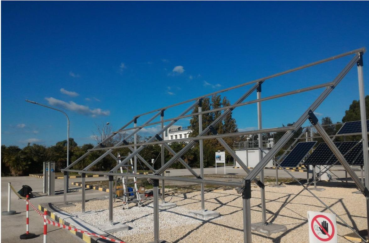
**Figura 5.14:** Struttura fissa adattabile per montaggio moduli.
