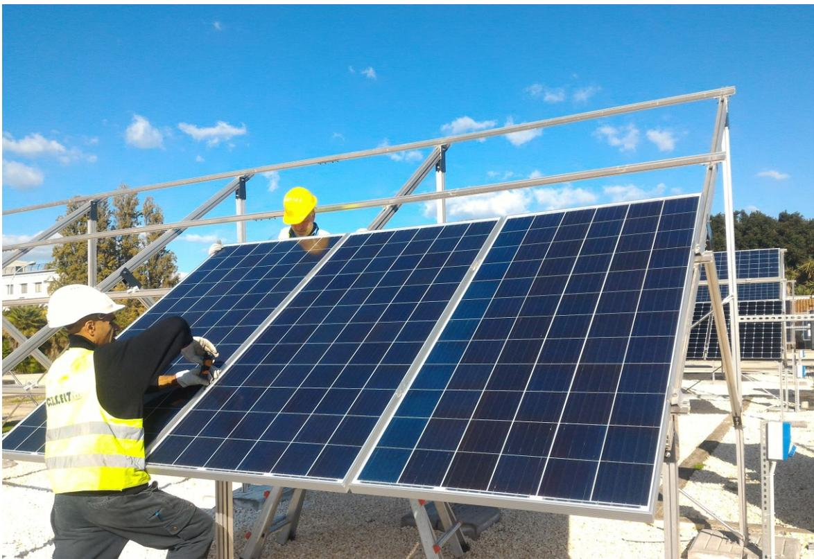
**Figura 5.15:** Montaggio degli 8 moduli Risen.
