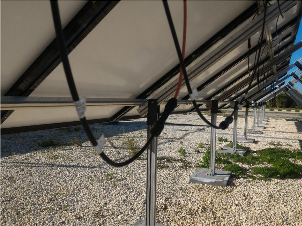
**Figura 5.16:** Connessione serie degli 8 moduli.
