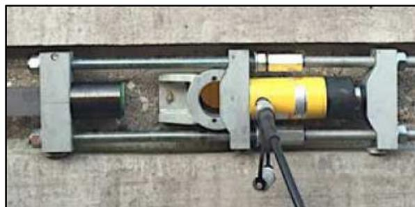
**Figura 3.3.4 : Tesatura della lastra pultrusa CFRP per mezzo di martinetto idraulico**
