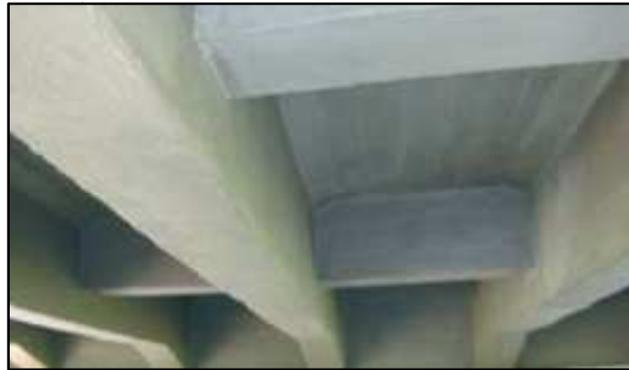
**Figura 1.2.16 : Protezione finale dei rinforzi in FRP dai raggi ultravioletti**
