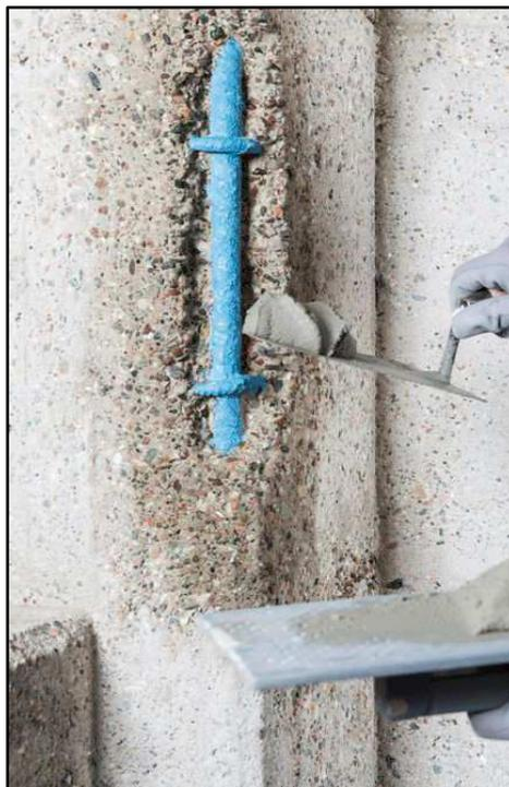
***Figura 1.2.9 : Ripristino con malta tixotropica***
