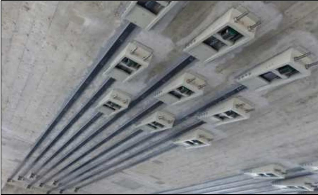
*Figura 3.3.5 : Gli StressHead-CarboStress post-tensioning systems installati e testati con successo*
