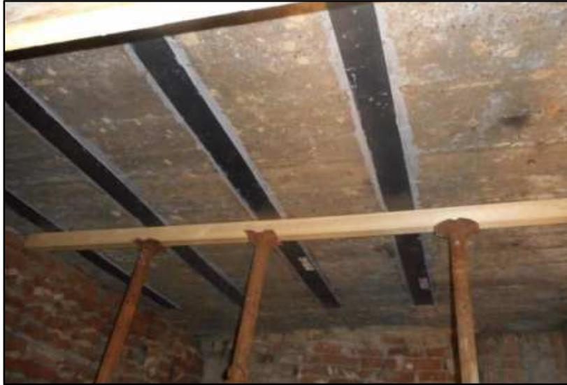
*Figura 1.3.3 : Lamine pultruse per rinforzare l'intradosso di una soletta in cemento armato*
