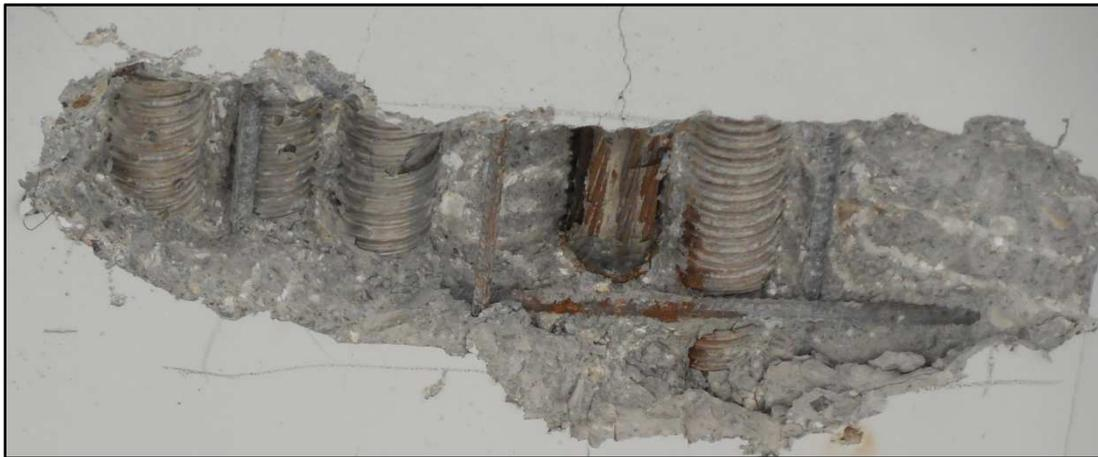
*Figura 4.2.1 : Demolizione controllata del calcestruzzo lungo le fessure*
