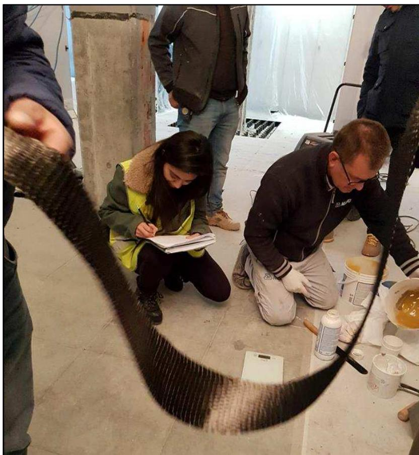
***Figura 1.2.15 : Partecipazione alla posa in opera di tessuti FRP, in occasione dello stage presso la Società di Ingegneria ENARCH S.r.l.***
