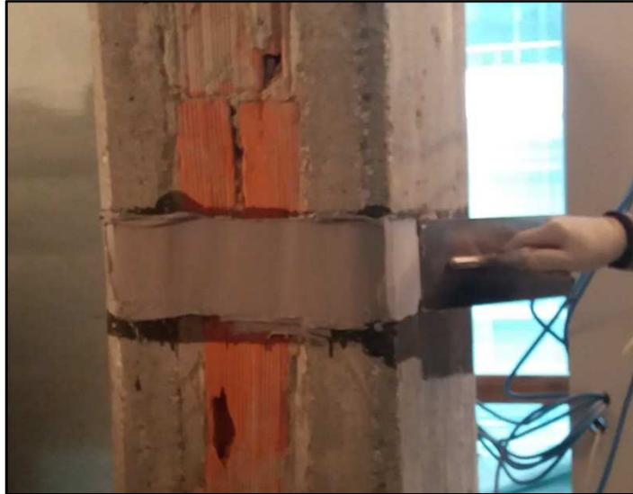
***Figura 1.2.11 : Applicazione a spatola della malta epossidica***
