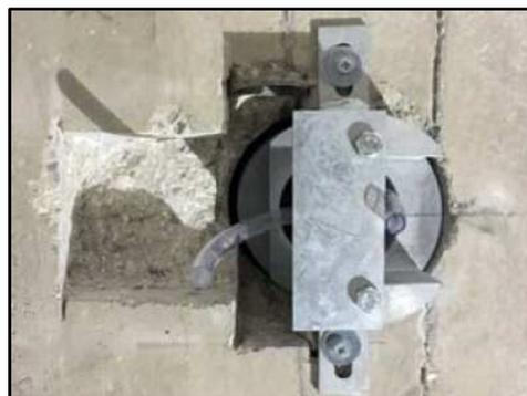
*Figura 3.3.3 : Installazione degli ancoraggi*
