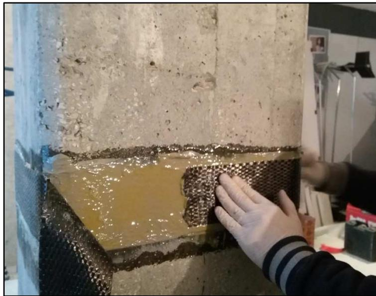
***Figura 1.2.12 : Stesura a secco del tessuto da impregnare***
