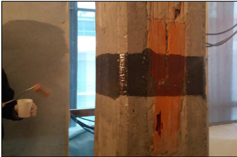
**Figura 1.2.10 : Applicazione del primer epossidico fluido**
