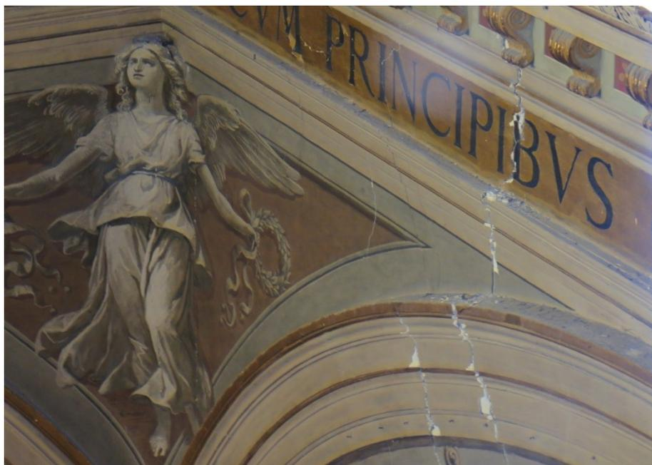
*Fig. Dettaglio lesioni sull'arco del Cappellone (Rif. Fotografie del sopralluogo a cura del Politecnico di Torino)*
