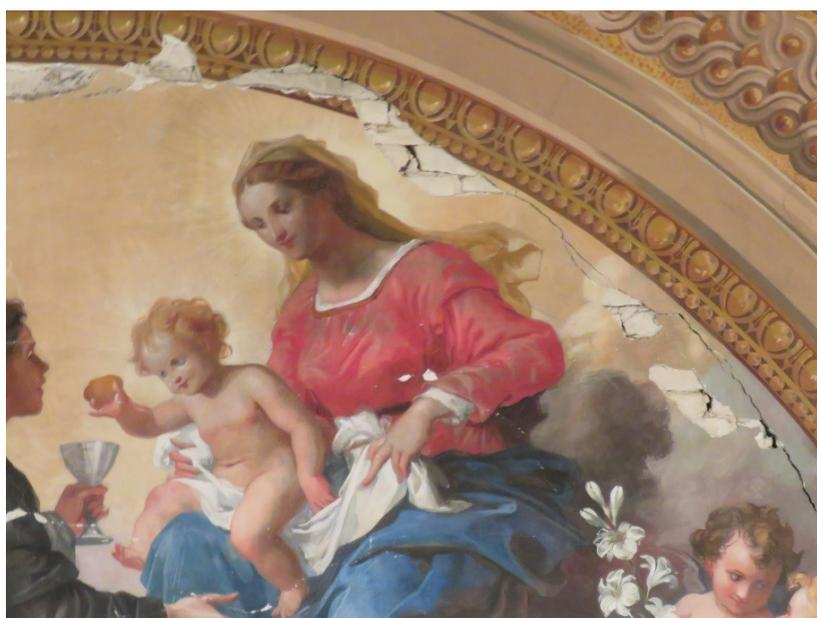
**Fig.** Dettaglio lesioni sull'arco del Cappellone (Rif. Fotografie del sopralluogo a cura del Politecnico di Torino)
