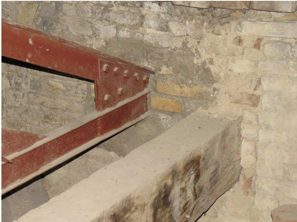
*Fig. Dettaglio dell'ammorsamento reticolare-parete (Rif. Fotografie del sopralluogo a cura del Politecnico di Torino)*
