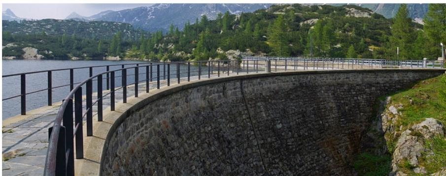
**Figura 2.4 Diga Pian del Becco (Bergamo) - diga a gravità in muratura di pietrame.**
