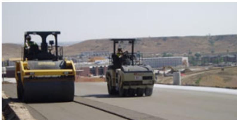
**Figura 2.13 Compattazione strato di calcestruzzo con rulli vibranti.**
