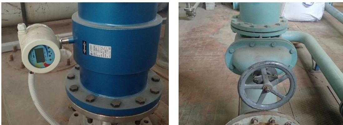
*Figura 14: misuratore di portata e saracinesca di regolazione*
