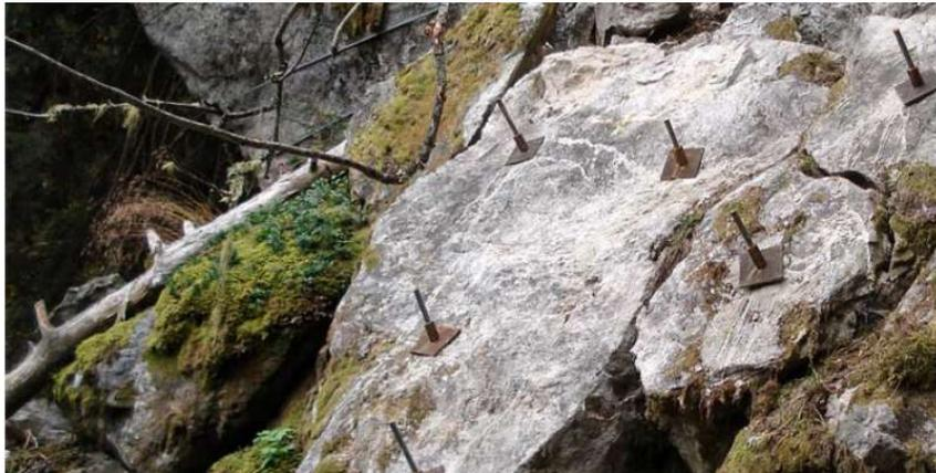
*Figura 6-1 Esempio di sistema di chiodatura su ammassi rocciosi. Fonte: Slides Prof.ssa M. Barbero*
