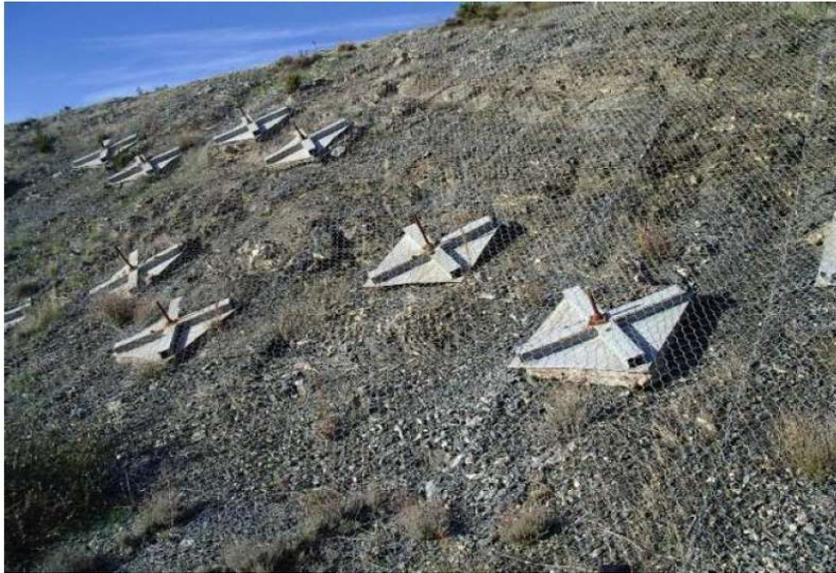
*Figura 6-2 Esempio di sistema di stabilizzazione accoppiato con chiodi e rete metallica in aderenza su ammassi rocciosi. Fonte: Slides Prof.ssa M. Barbero*
