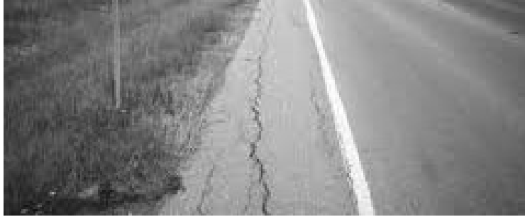
Figura1.3 edge cracking
