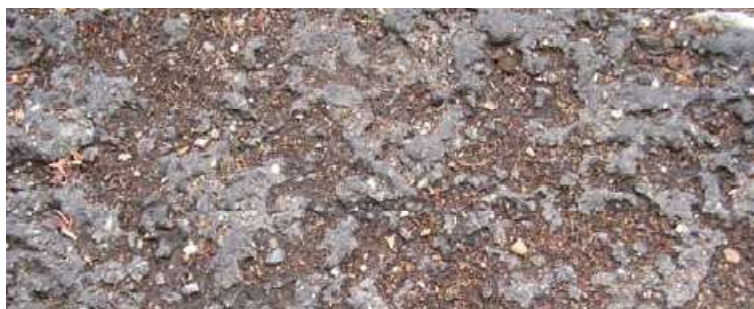
Figura1.12 scagliatura della superficie (Di Mascio P., Miseri F., Moretti L.)
