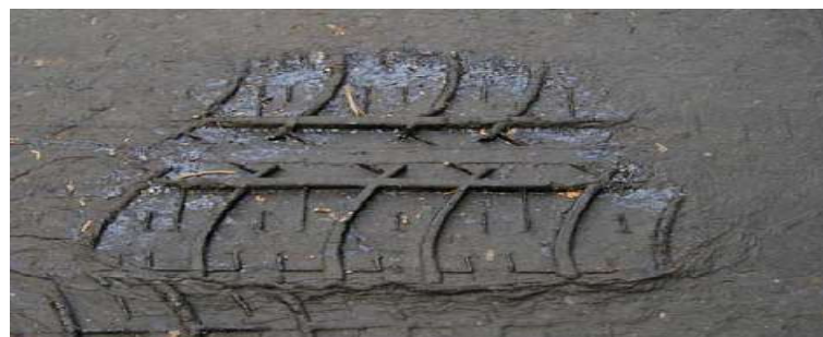
Figura1.11 essudazione di bitume (Di Mascio P., Miseri F., Moretti L.)
