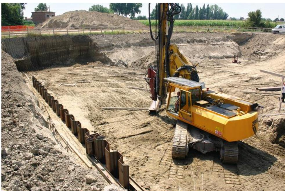
Figura 22: Palancolate metalliche (Fonte / ELTO, [https://www.elto.it/site/palancole\\_acciaio\\_gallery.php](https://www.elto.it/site/palancole_acciaio_gallery.php), [03/10/2017])
