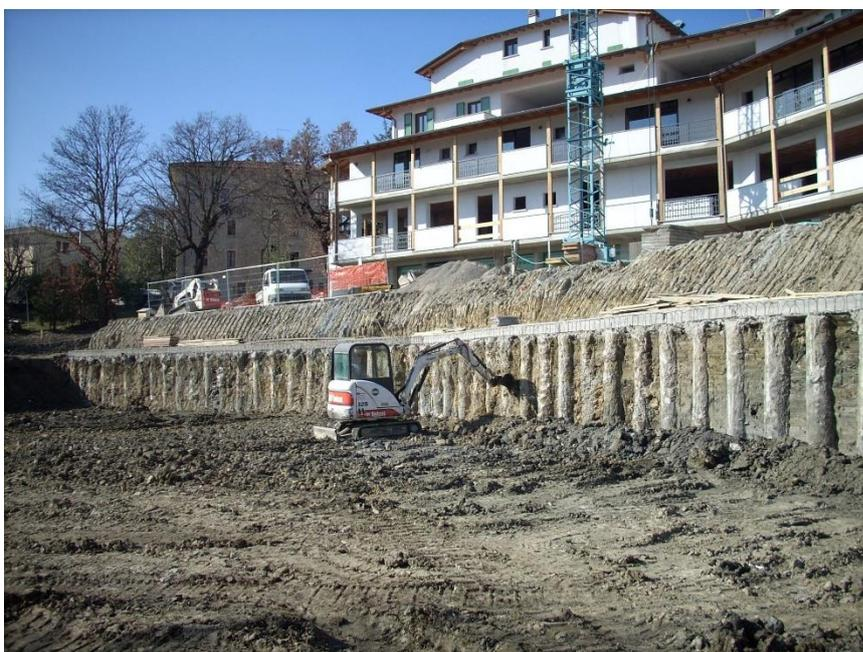
Figura 19: Paratia di pali trivellati (Fonte / Bertoia Costruzioni, <http://www.bertoia.it/lavorazioni/pali-trivellati-per-fondazioni-e-consolidamento-terreni/>, [20/09/2017])
