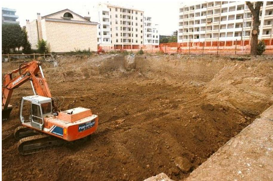
Figura 18: Scavo di sbancamento (Fonte / <http://carblat.ru/scavi-di-sbancamento/> [06/10/2017])
