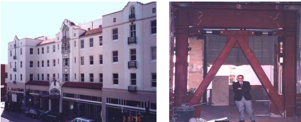
Figura 2.14: Intervento di recupero dell'Hotel Woodland, California (1928): (a) vista prospettica dell'hotel; (b) dissipatori utilizzati.
