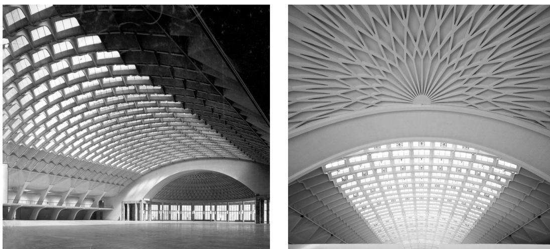
Figura 3.8: Salone B: (a) veduta dello spazio espositivo; (b) particolare dell'abside (fonte: <http://www.costruirecorrettamente.org>)
