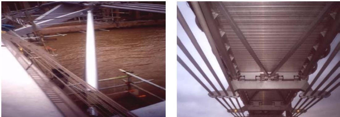
Figura 2.16: Posizioni dei dissipatori sul Millenium Footbridge; Londra (1999): (a) sulle ali della passerella; (b) come controvento sotto l'impalcato della passerella.
