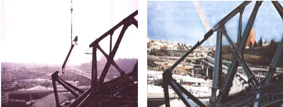
Figura 2.15: Montaggio dei dissipatori nella copertura del nuovo stadio da baseball di Seattle
