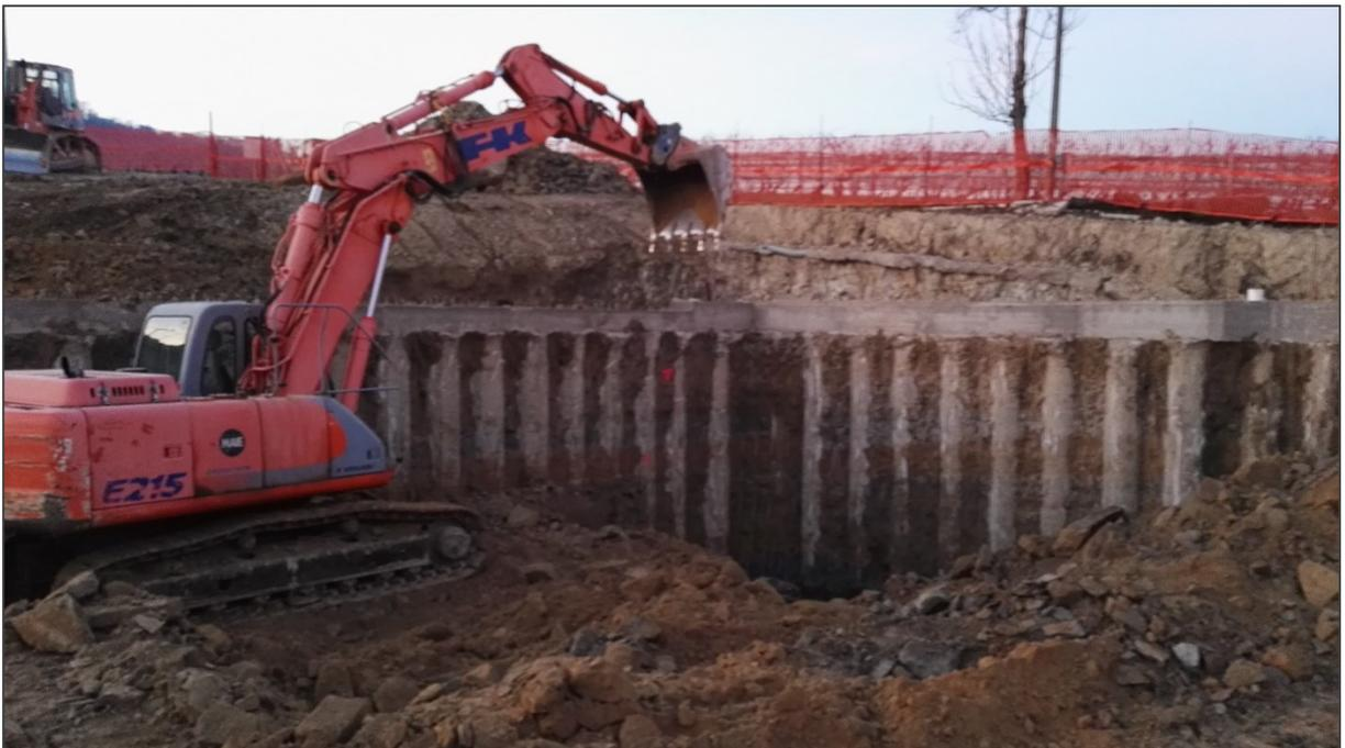
Figura 7.2 Scavo mediante benna mordente in cantiere
