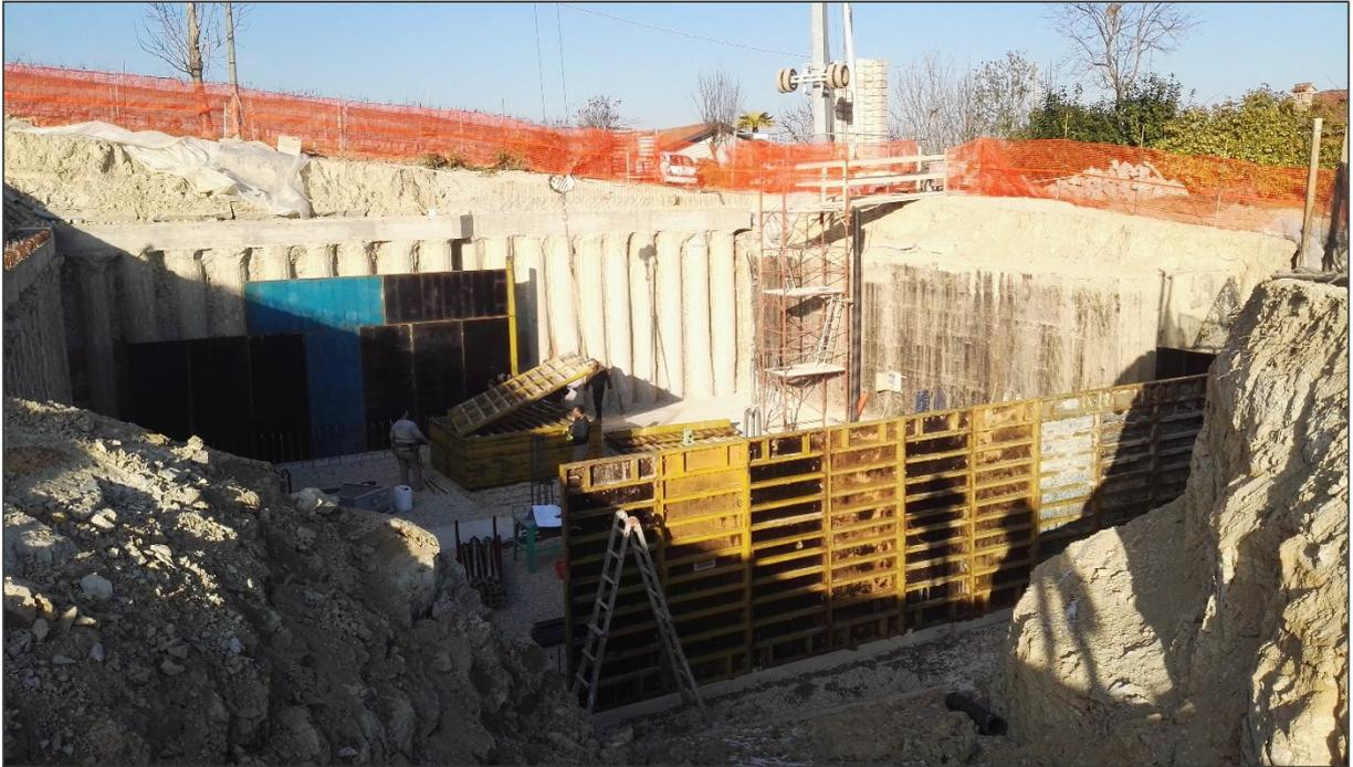
Figura 7.5 Realizzazione dei muri in cemento armato
