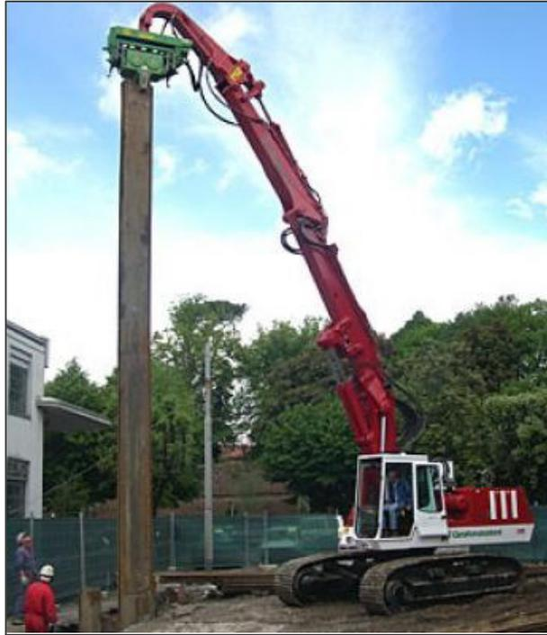
Figura 2.9 Infissione di palancole in acciaio (www.geofondazioni.it)
