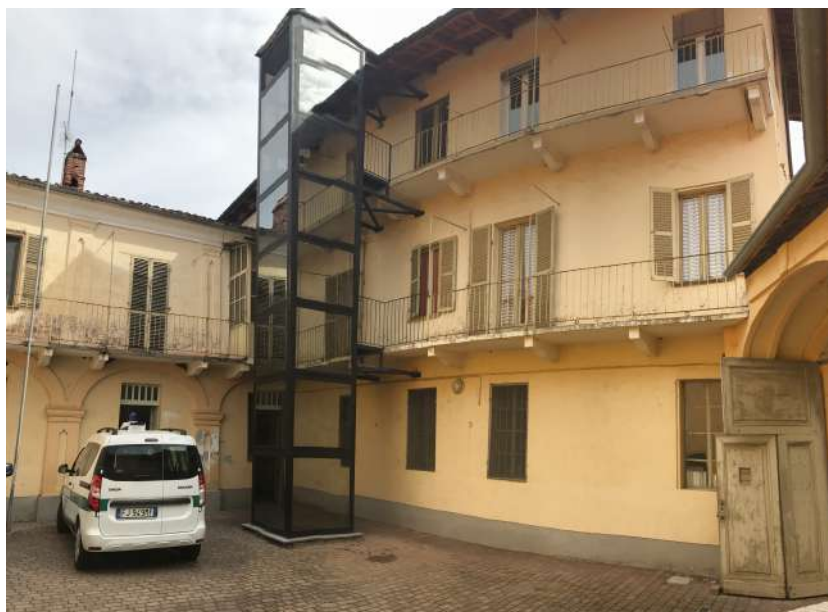
Figura 5-6 – Foto scattata dal cortile interno, 10/09
