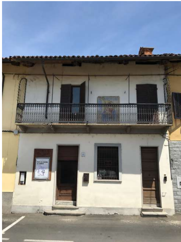
Figura 5-5 – Foto della facciata principale lato strada, 26/05
