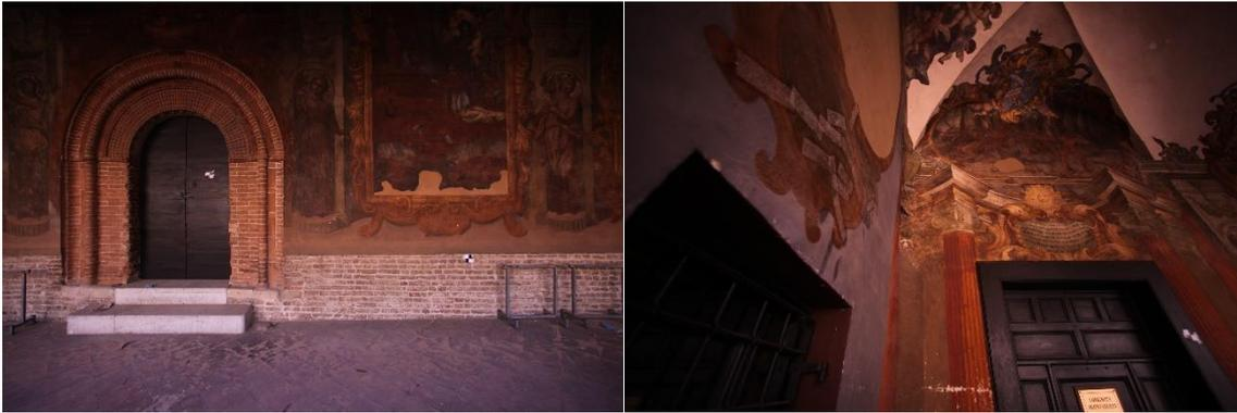
Figura 5.15- Fotogrammi acquisiti con asse della camere perpendicolare all'oggetto(A) e con asse inclinato (B)
