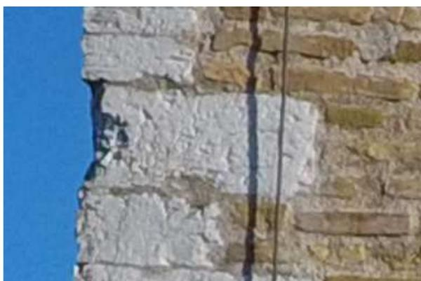
Figura 131: disgregazione di un singolo conco.
