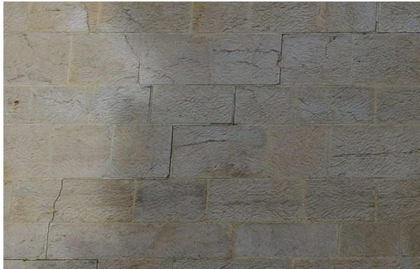
Figura 133: fessurazione lungo la parete muraria in pietra del prospetto Sud.
