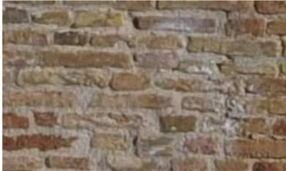
Figura 132: efflorescenza lungo la parete muraria in mattoni pieni del prospetto Ovest.
