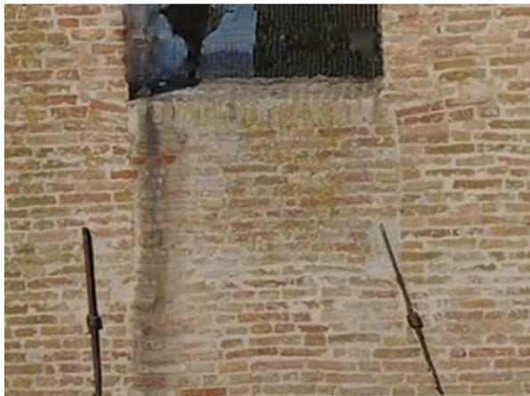
Figura 129: colatura in corrispondenza dell'apertura Sud dell'ultimo piano della Torre.
