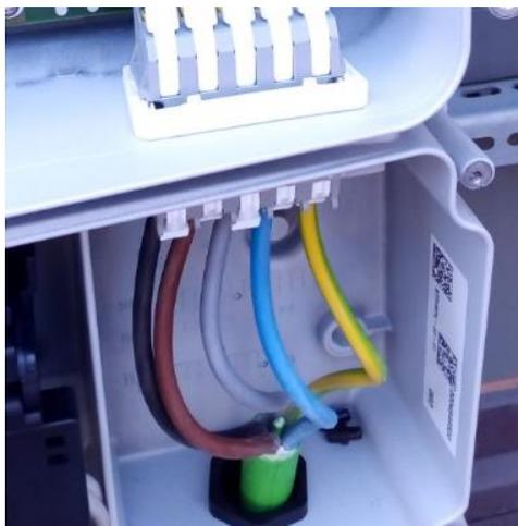
Fig.5.3 Cavo PE interno all'inverter
