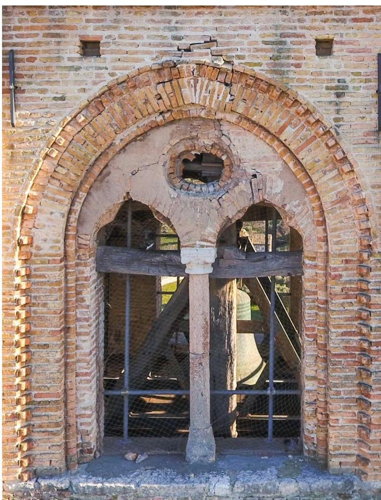
*Fotografia della bifora ovest del campanile del Duomo Vecchio di San Severino, danneggiata dallo sciame sismico dell'agosto 2016.*
