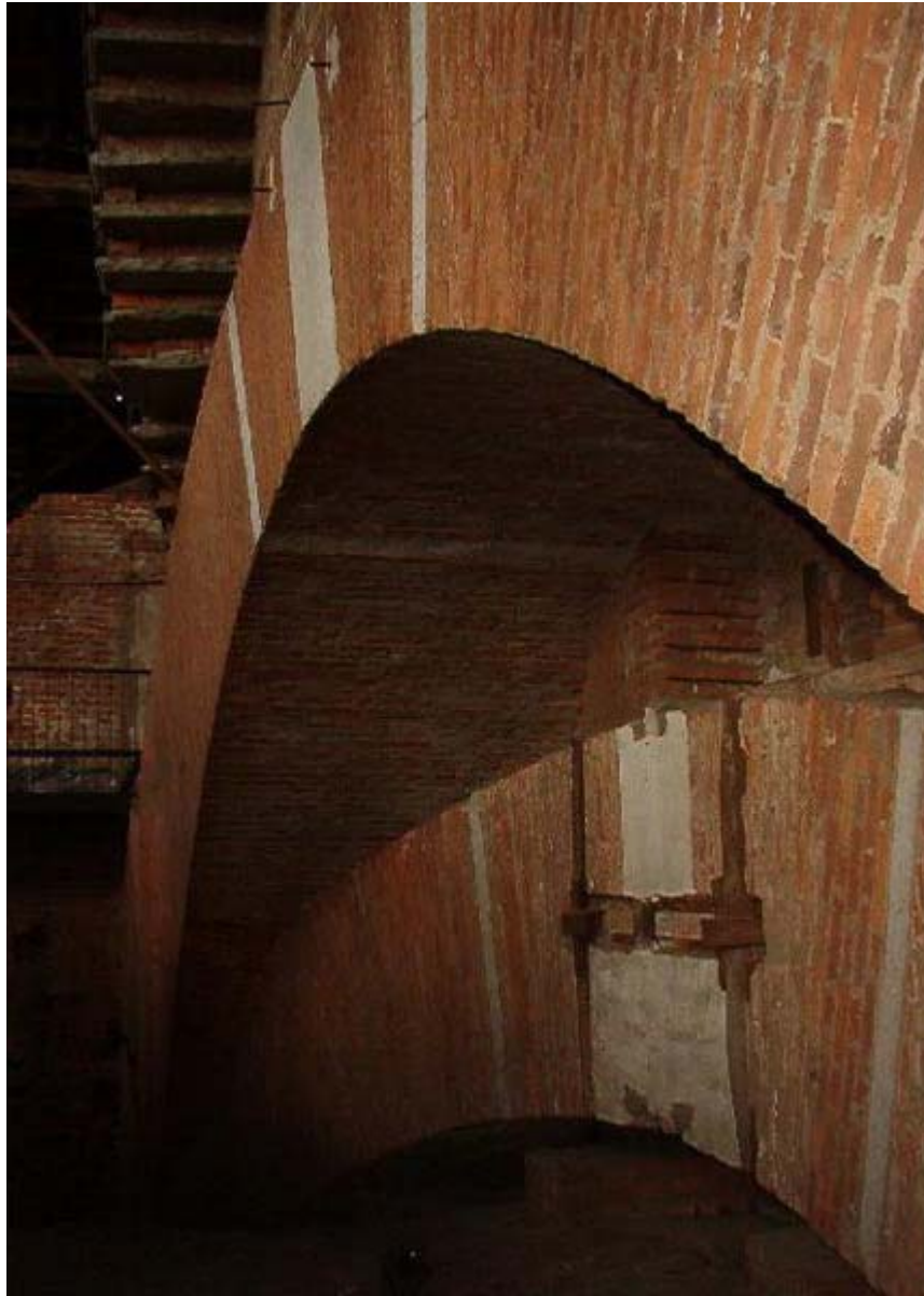
Gli arconi d'imposta della cupola novarese, complessa, ardita e geniale soluzione di trasmissione del carico ai piloni sottostanti (Sabrina Fassi)
