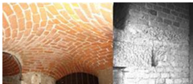
Due esempi delle più significative tecniche architettoniche e costruttive: la volta "ad imbuto" o "a fungo" perfettamente adattabile al "sistema antonelliano" e l'utilizzo di legati lapidei intercalati al laterizio (Sabrina Fassi)
