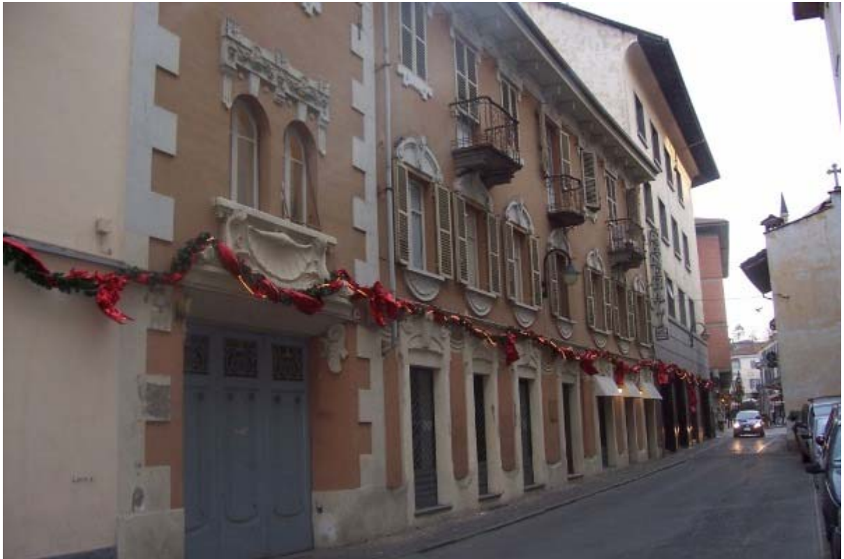
Edificio civile abitazione, Via S. Rocco, 20
