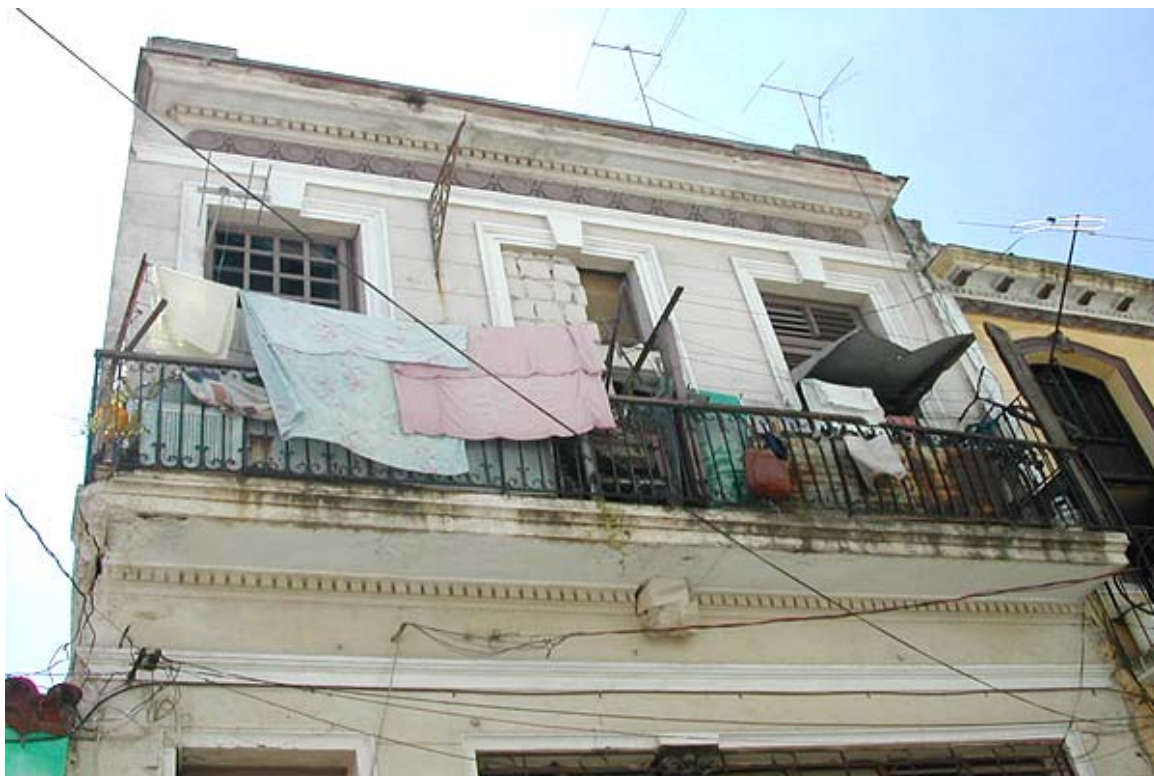
Parte esterna dell'edificio (foto E. Castaldi)
