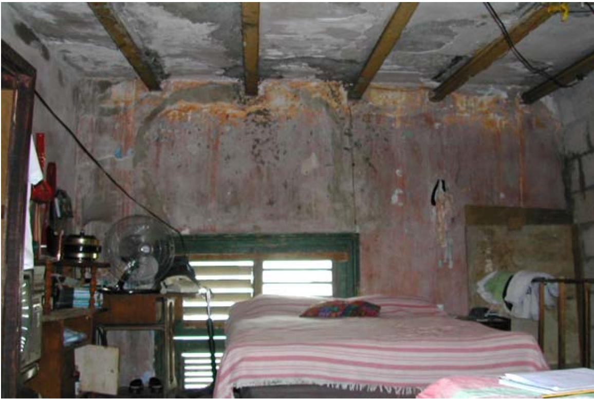
Parte interna dell'edificio (foto E. Castaldi)
