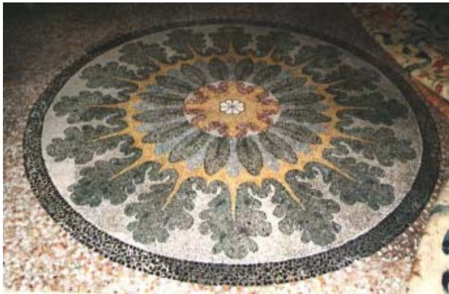
Decorazione centrale del pavimento alla veneziana della camera da letto della Duchessa nella Palazzina di Caccia di Stupinigi
