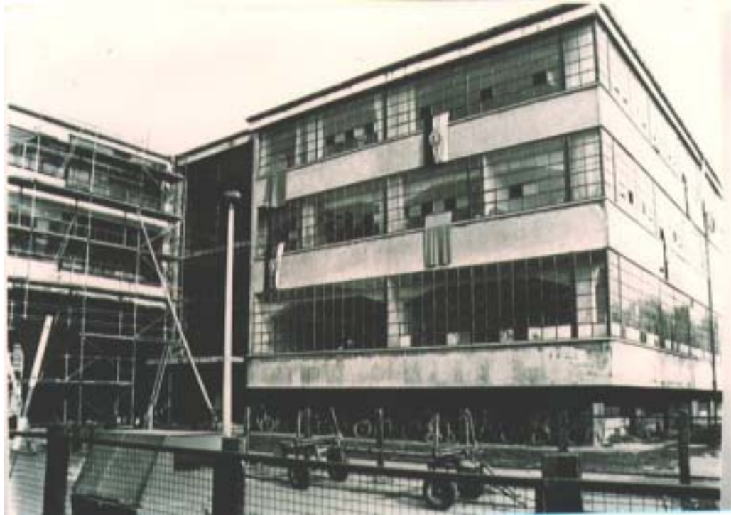
Il complesso del Bauhaus in fase di restauro (1976), Bauhaus Arkiv Dessau.
