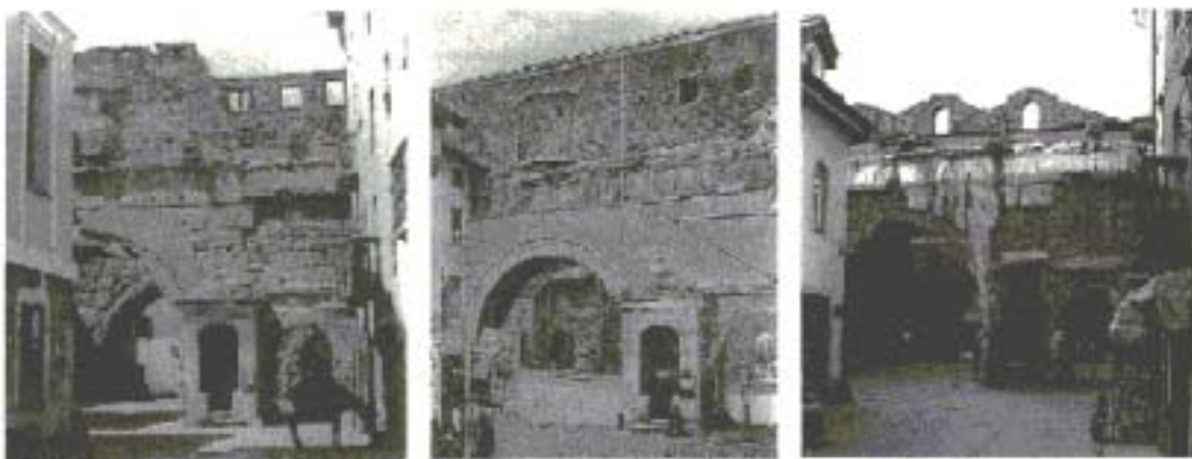
(fig. 1) La facciata esterna della Porta Praetoria prima dei restauri del 1881, dopo tali restauri e nella situazione attuale. (BREL, Aosta).
