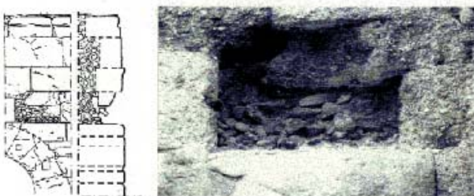
(fig. 3) Particolare della facciata interna della Porta che evidenzia l'esistenza del nucleo di opus caementicium e schema del saggio della muratura.
