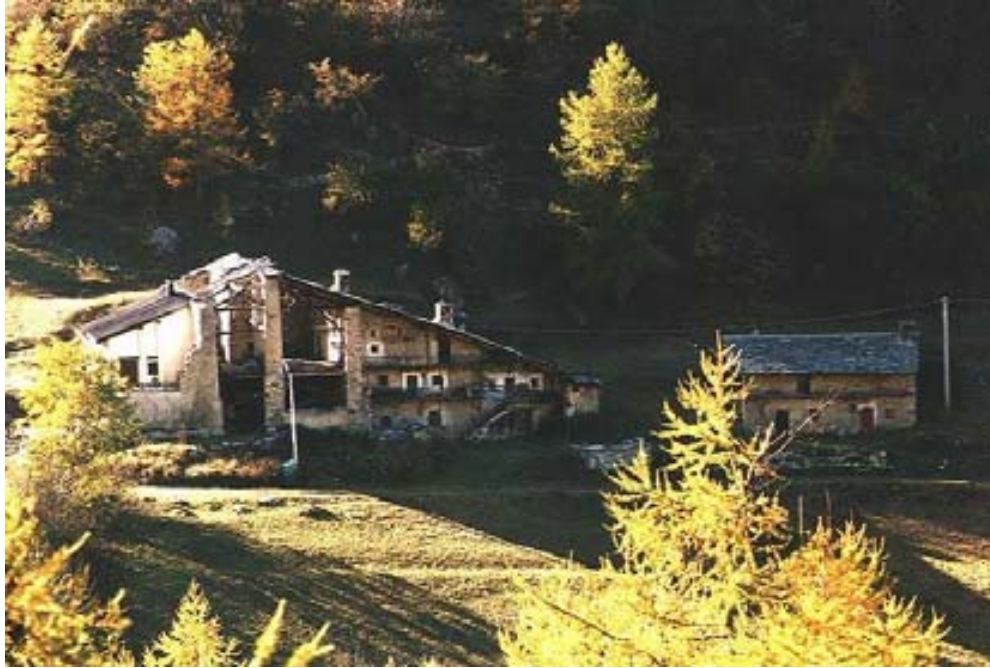
Casa Corte: veduta d'insieme
