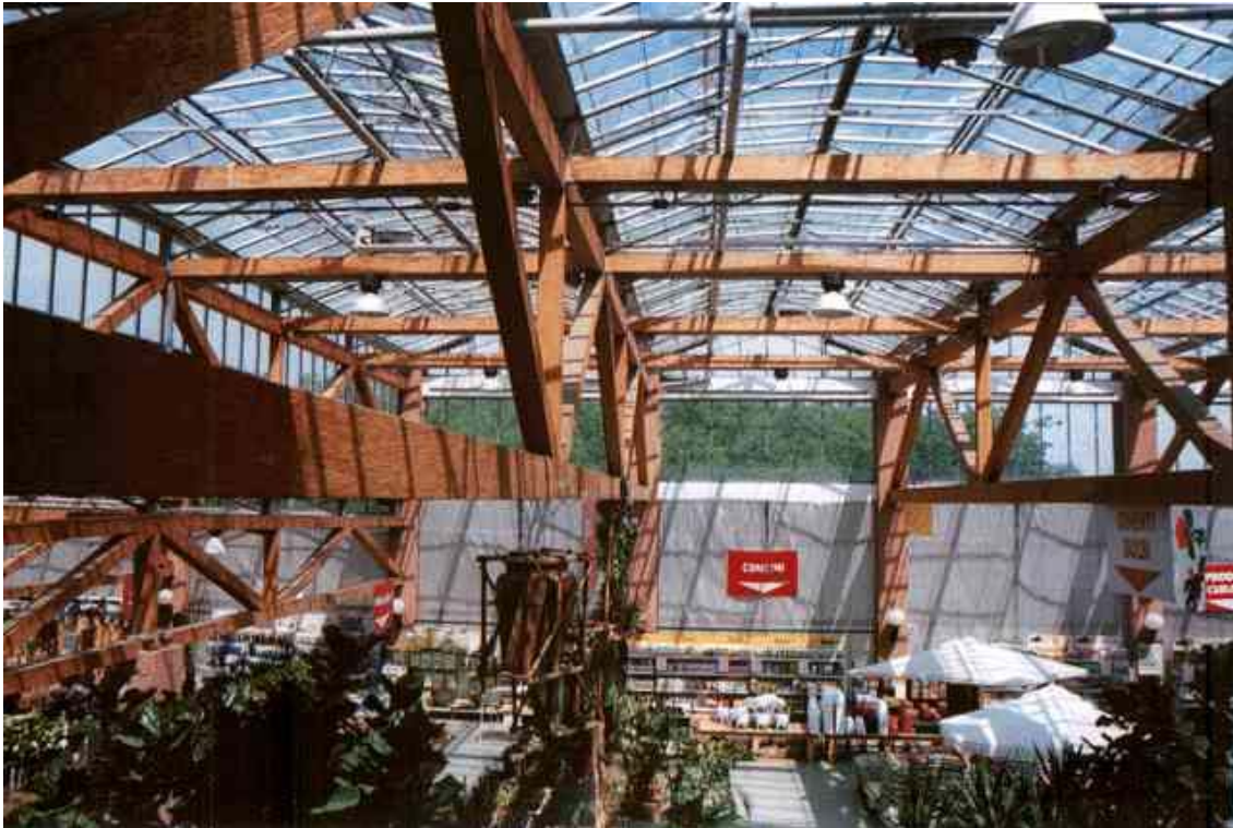
Figura 1 La struttura reticolare in Parallamâ dell' Eurogarden di Cermenate
