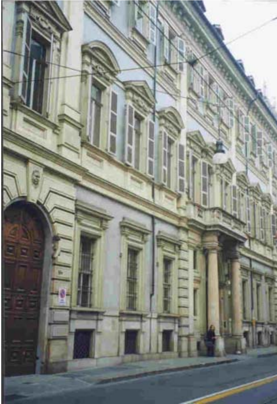
Fig. 1. Palazzo Birago di Borgaro (F. Juvarra 1716). Example of façade with giant strata
