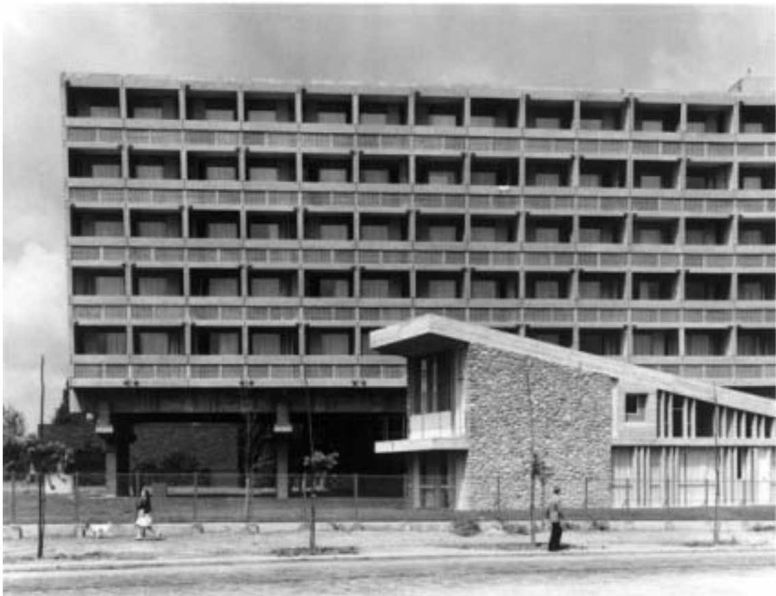
Facciata est a lavori ultimati giugno 1959. FLC L 2 643
