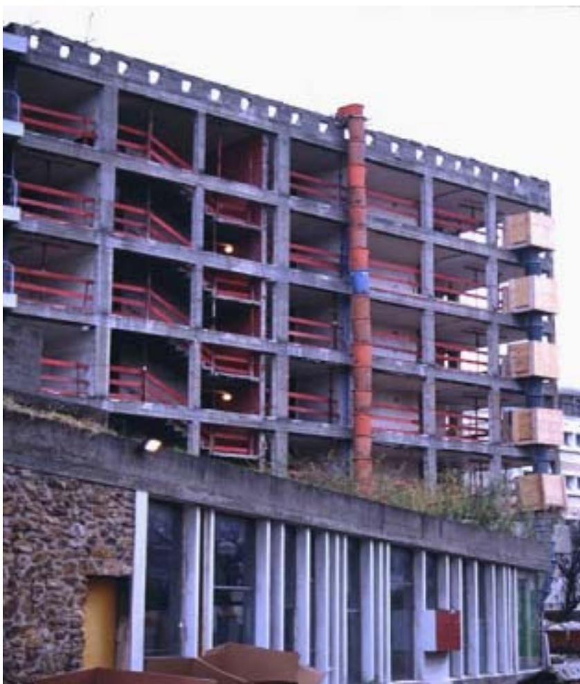
Demolizione dei tamponamenti della facciata nord-ovest. Dicembre 1999 Fda.
