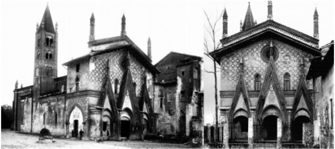
Fig.2: La chiesa di Sant'Antonio di Ranverso prima e dopo l'intervento reintegrativo di Cesare Bertea del 1914-20
