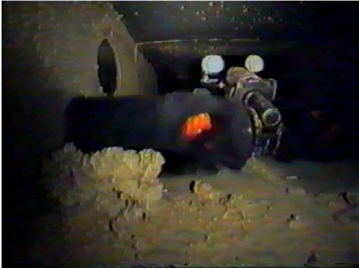
Nell'immagine riportata si illustra un mezzo meccanico utilizzato per l'esecuzione di attività di scovolatura con apparati complessi
