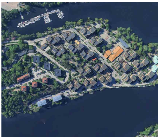
Fig. 60. Ortofoto della fermata periferica di Ekensberg. Fonte: Google Earth, ottobre 2025
