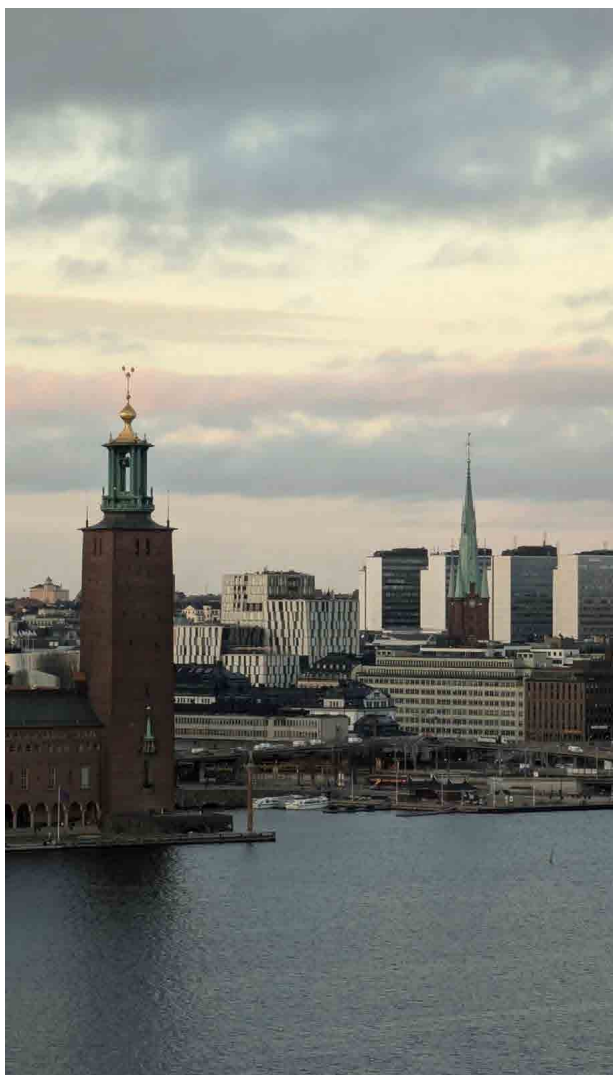
Fig. 29. Vista verso Stadshuset e il quartiere Norrmalm Foto realizzata dalle autrici, ottobre 2024.
