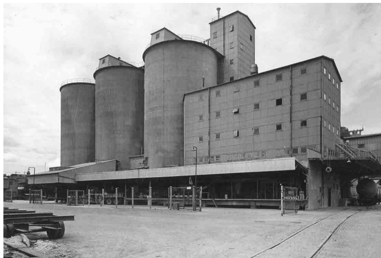
Fig. 157. Silos dell'industria Cementa, 1966. Fonte: Stadsmuseet
