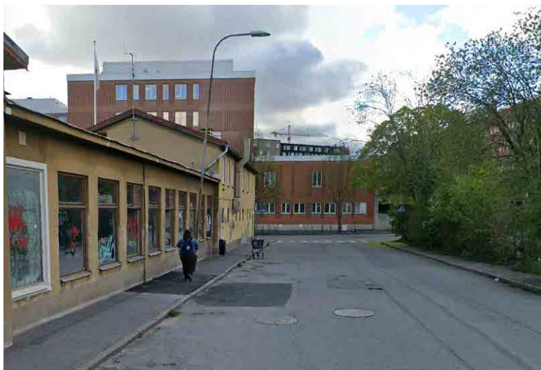
Fig. 141. Officina per il personale Cementa in stato di abbandono. Fonte: Google Earth, 2025.
