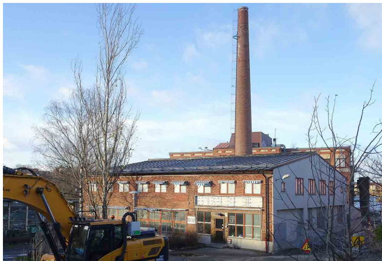
Fig. 132. Ångpannecentralen, centrale termica. Autore: Holger Ellgaard, 2021.
