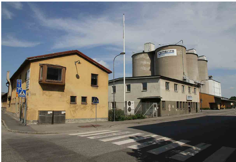
Fig. 143. Officina per il personale affiancata agli Uffici Cementa e ai silos. Autore: Patrik Nylin, 2015
