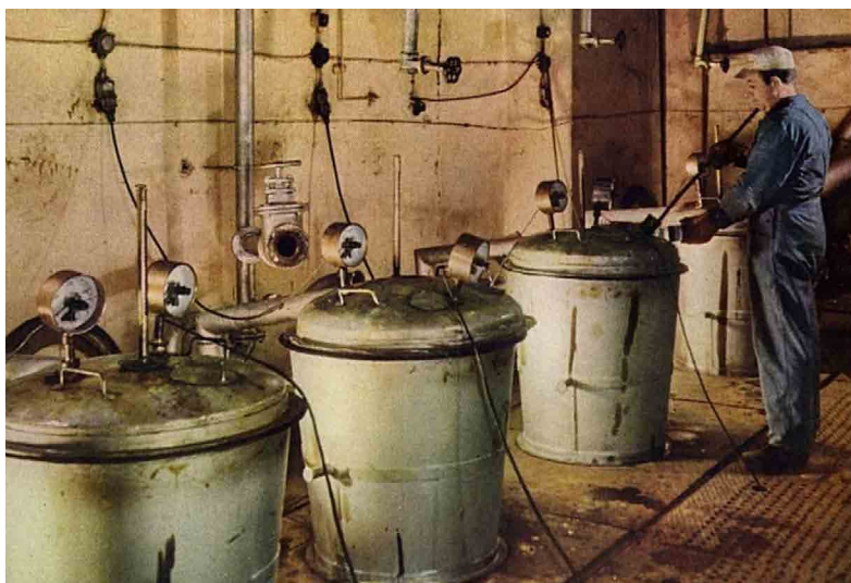
Fig. 136. Bollitura della vernice nella Smälten, 1949. Fonte: Beckers arkiv
