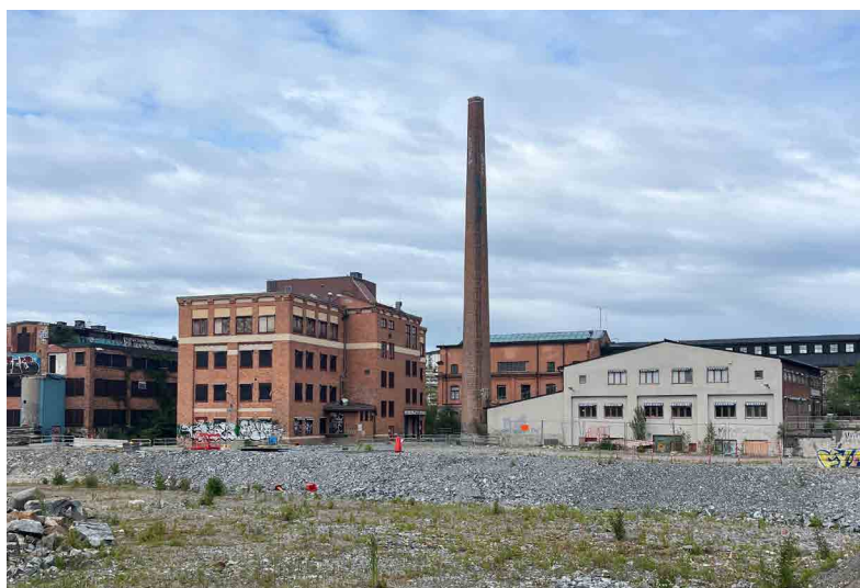
Fig. 133. A destra la Ångpannecentralen, centrale termica e a sinistra la Förbundsfabriken, 2025. Foto realizzata dalle autrici.
