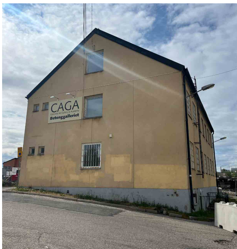
Fig. 150. Edificio della Concrete Art Gallery and Academy, 2025. Foto realizzata dalle autrici.
