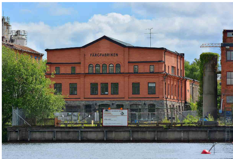
Fig. 135. Edificio della Palmcrantz, oggi convertito nello spazio museale della Färgfabriken. Autore sconosciuto., 2021.
