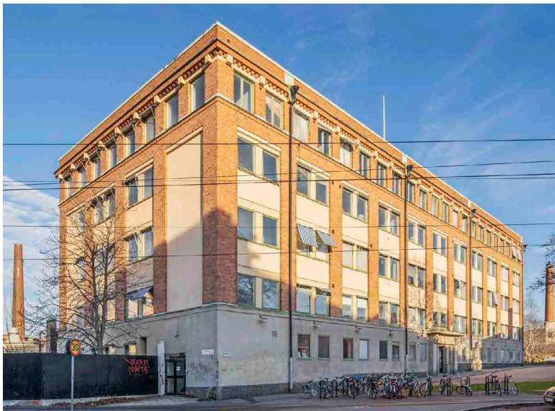
Fig. 123. Beckerhuset, edificio per uffici di Wilhelm Becker. Autore: Petter Cohen, 2012.
