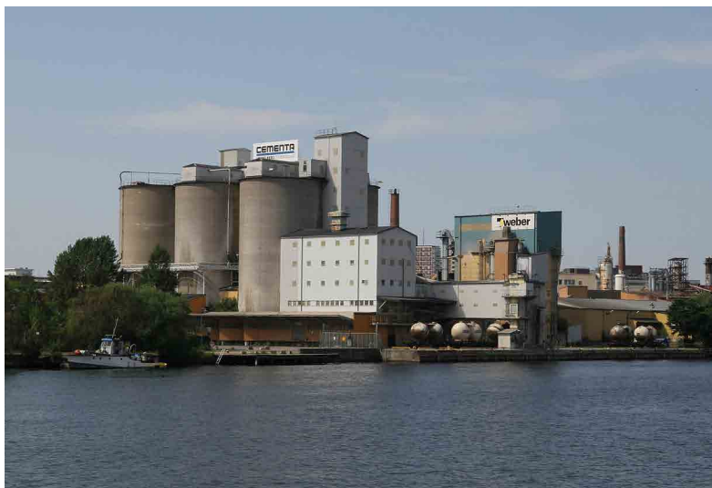
Fig. 154. Impianto dei silos e della torre di carico visto dalla sponda opposta del canale. Autore: Patrik Nylin, 2015.
