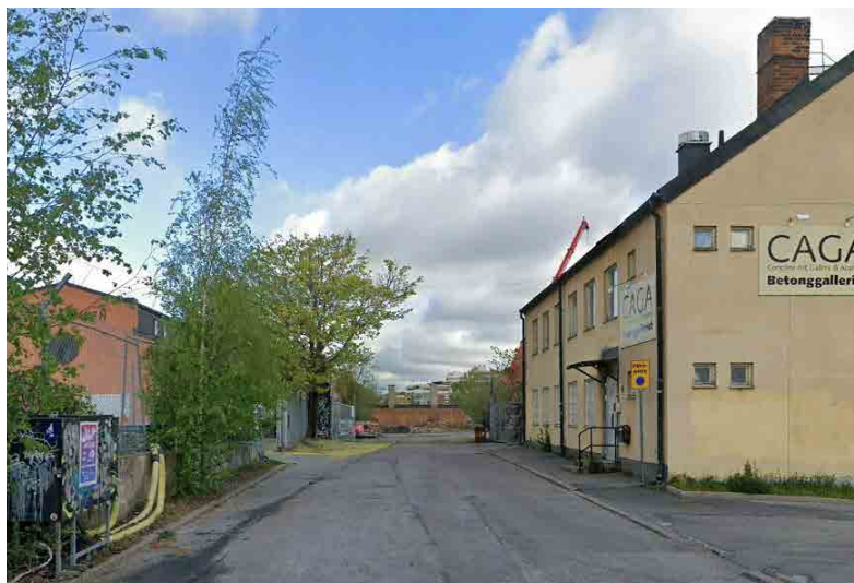
Fig. 148. Strada interna al lotto di Lovholmen; edificio CAGA sulla destra e Färgfabriken sulla sinistra. Fonte: Google Earth, 2025
