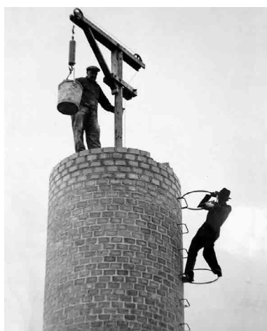
Fig. 131. Ångpannecentralen, centrale termica, costruzione della ciminiera, 1945. Fonte: Beckers arkiv
