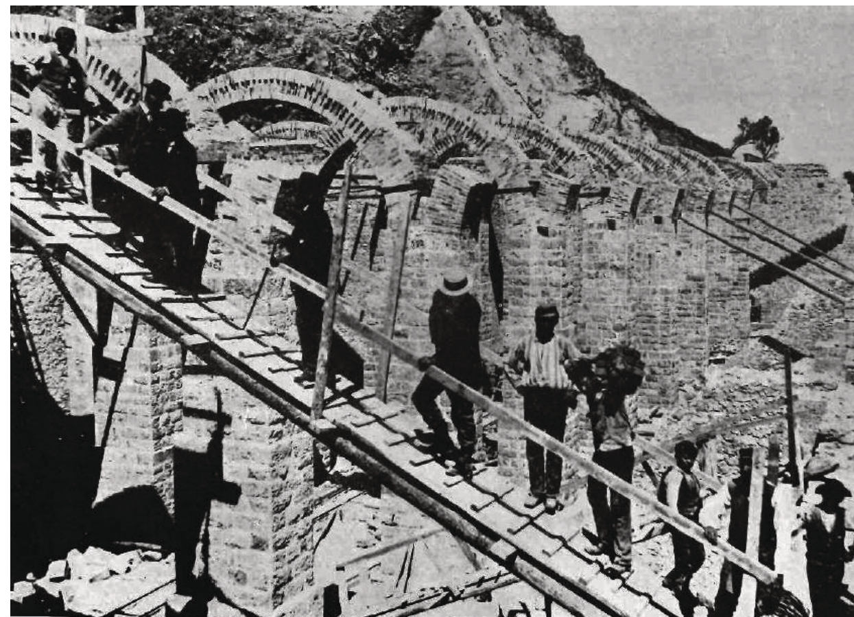
Fig. 14 Lavori di costruzione dell'acquedotto Scillato (1894)
