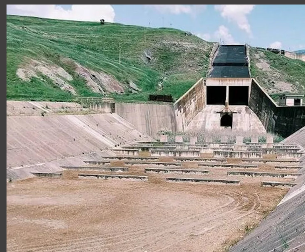
Fig. 12 Diga incompiuta di Blufi
