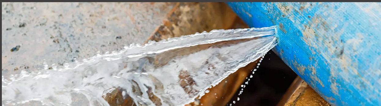
Fig. 7 Perdite idriche nelle condotte
