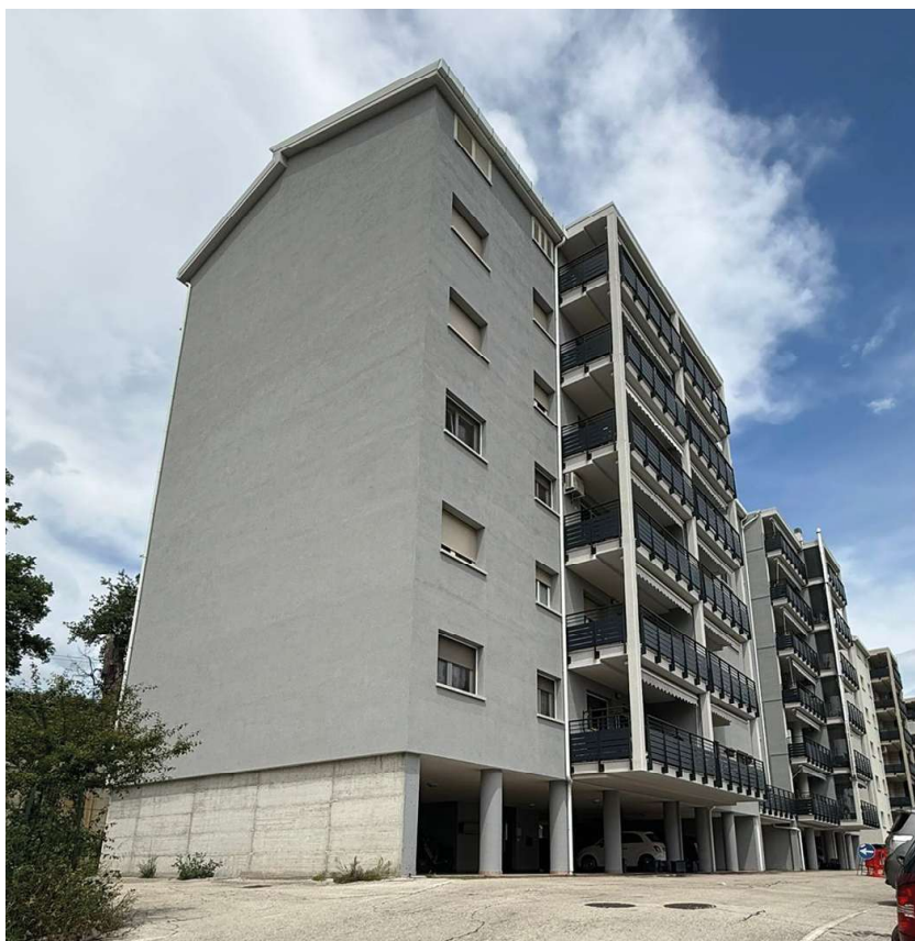
Figura 3.5 — Vista esterna dell'edificio nello stato post operam. Rilievo fotografico del prospetto principale post interventi di riqualificazione energetica.
