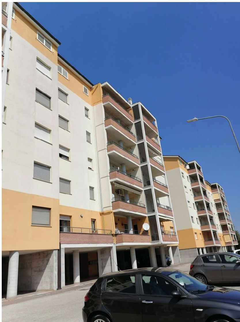
Figura 3.3 — Vista esterna dell'edificio nello stato pre retrofit. Rilievo fotografico del prospetto principale prima degli interventi di riqualificazione energetica. Fonte: rilievo fotografico dell'autore.
