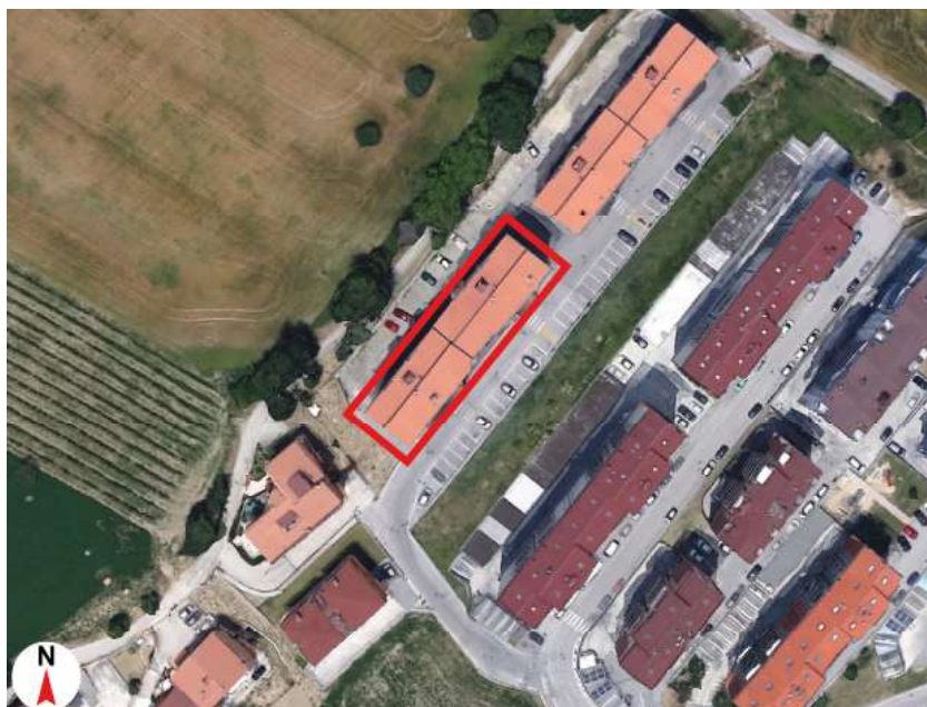
Figura 3.1 — Inquadramento satellitare dell'edificio oggetto di studio. Individuazione del fabbricato nel contesto urbano di Colleatterato Basso, Teramo.
