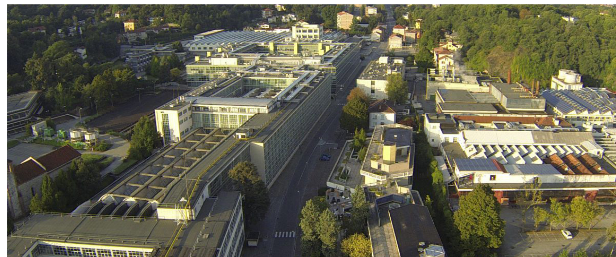
Figura 23 Vista aerea degli edifici ex Olivetti presso Ivrea. Crediti: Ministero della Cultura
