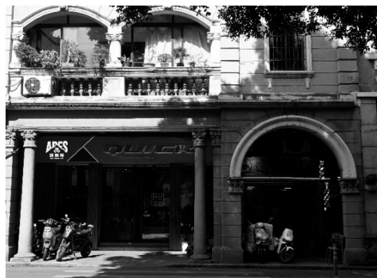
Fig 6-16 广州同福西路骑楼装饰样式
