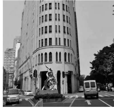
Fig 6-18 广州沿江西路骑楼
