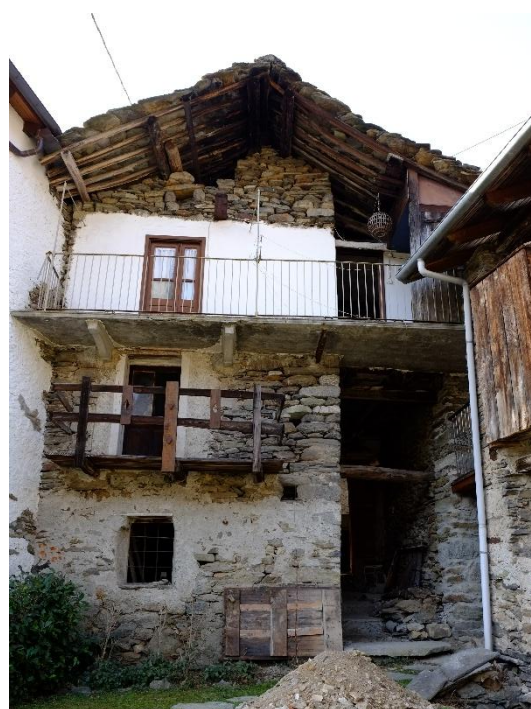
Sopra: Prospetto Sud-Ovest del fabbricato Sotto: Prospetto Est del fabbricato
