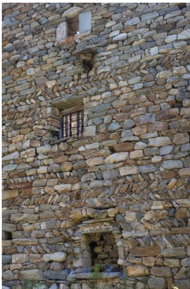
Dettaglio delle caratteristiche pietre posate "a spina di pesce"
