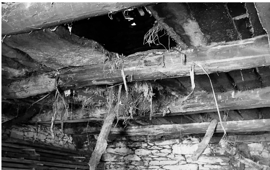
Solaio di interpiano interno
