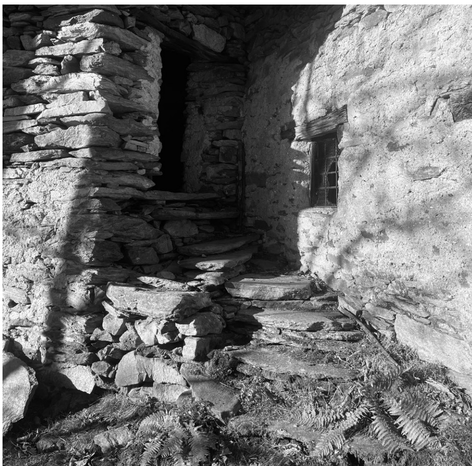
Particolare costruttivo della scala esterna
