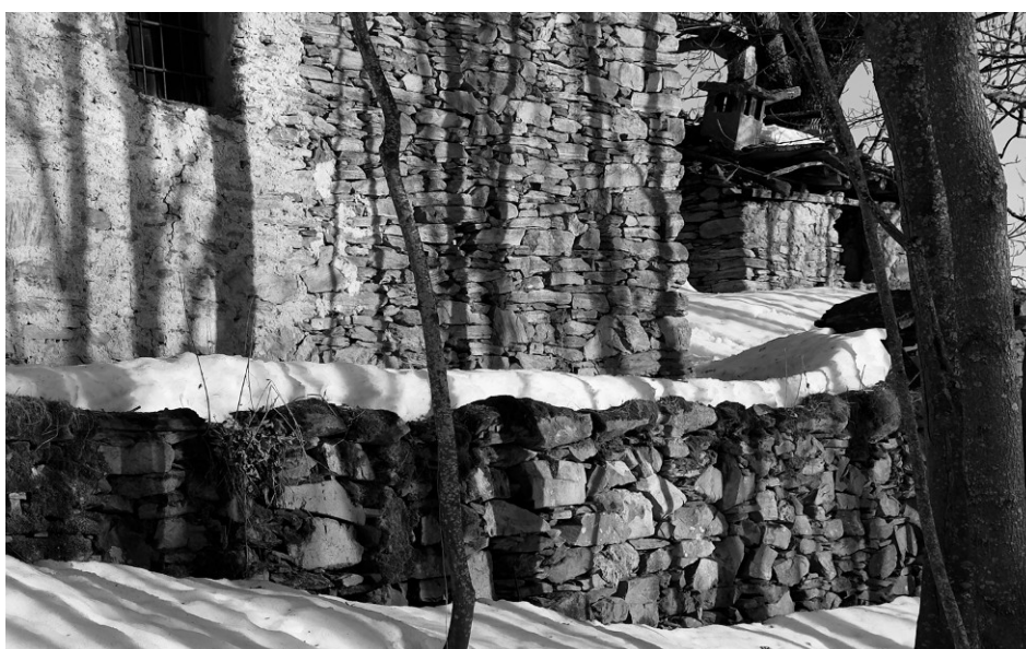
Muretto di contenimento a secco
