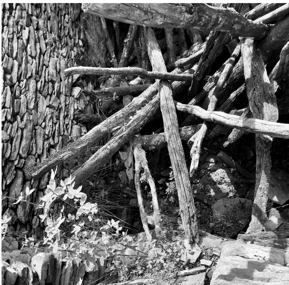
Interno di rudere Blocco D
