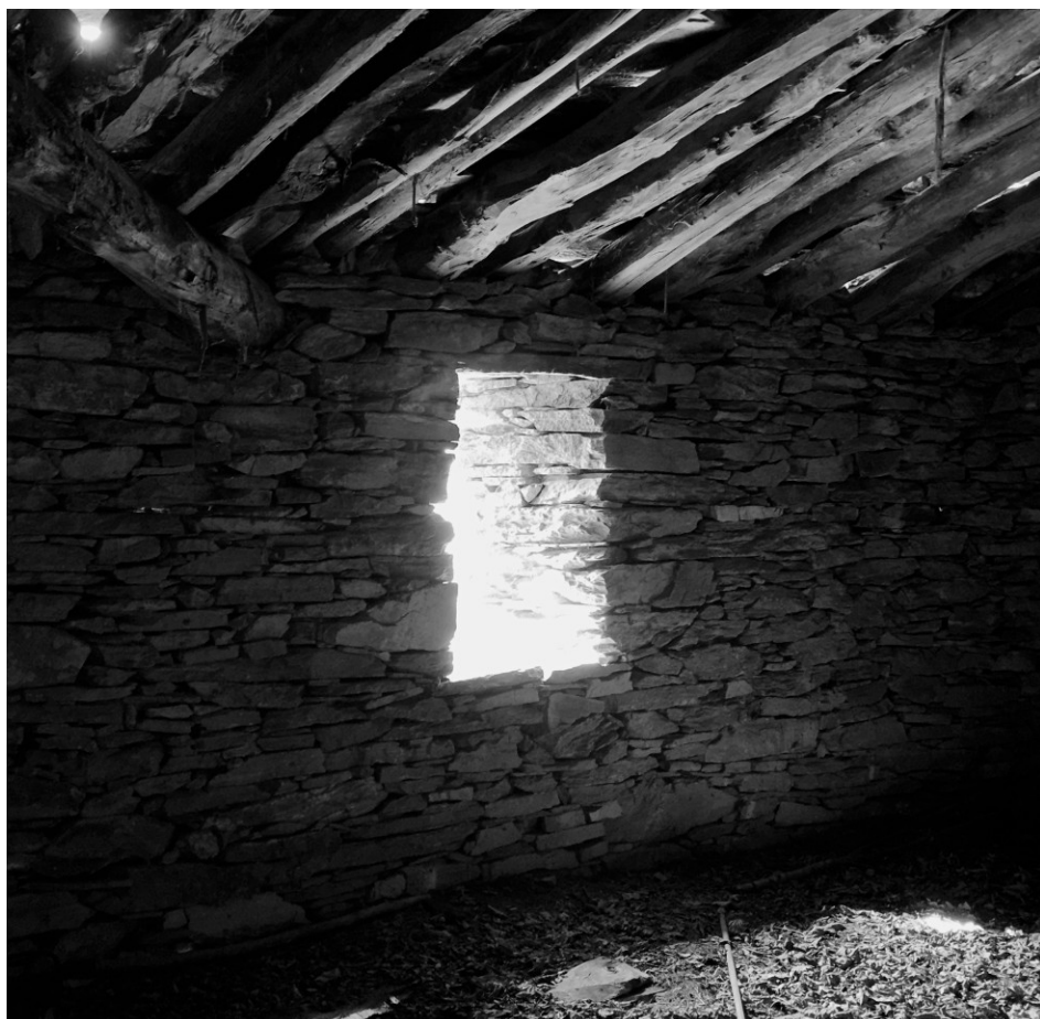
Muratura interna Blocco B
