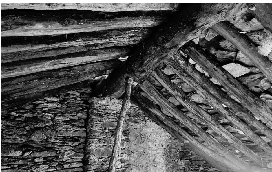
Particolar dell'orditura lignea interna
