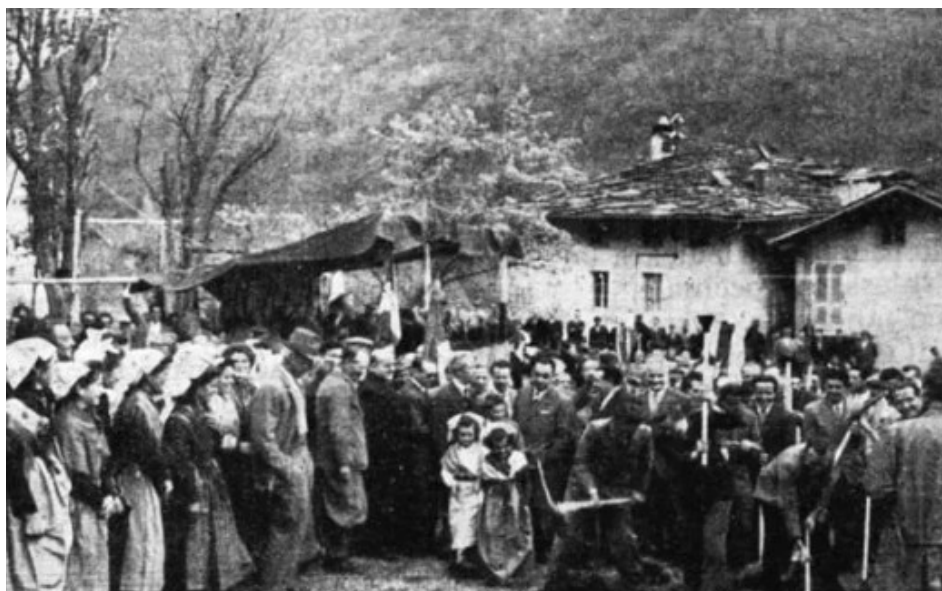
Inaugurazione della strada di Lities
