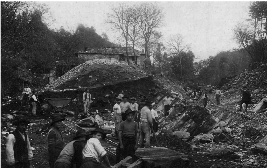
Costruzione della ferrovia
