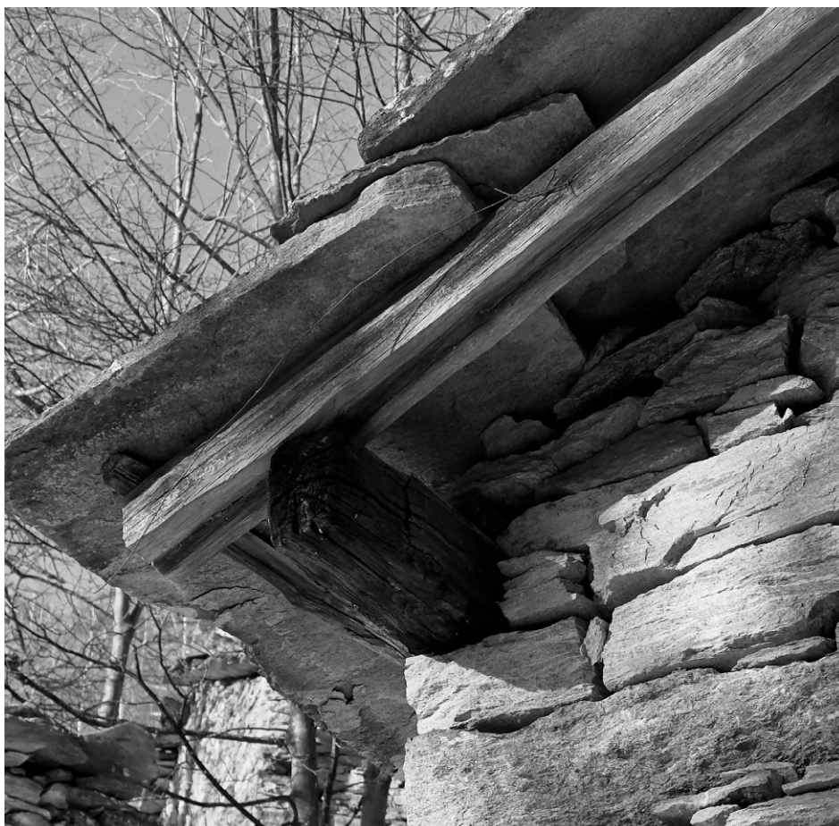
Dettaglio rasal della copertura
