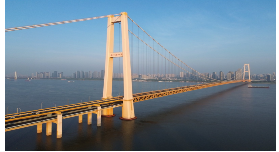
(d) Yangsigang Yangtze River Bridge
