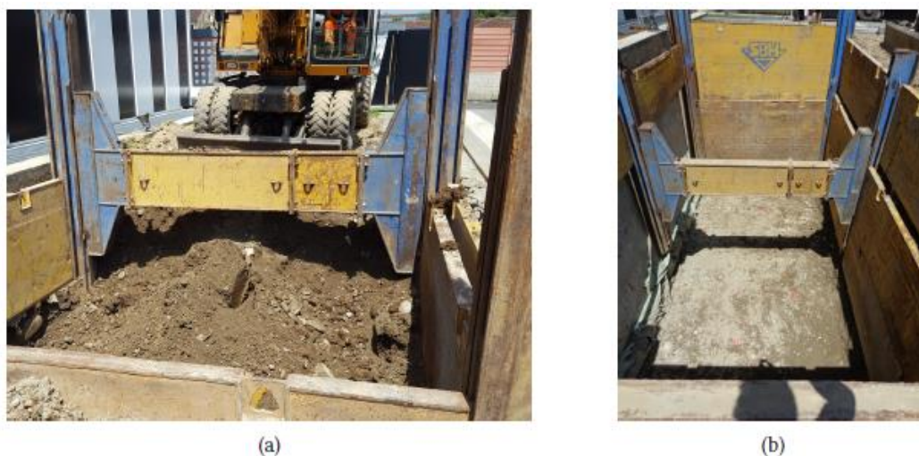
Figura 28: Lavori di scavo e blindatura per il prototipo GeoThermSkin; (a) fase iniziale e (b) fondo scavo livellato per la posa dei tubi 4 .
