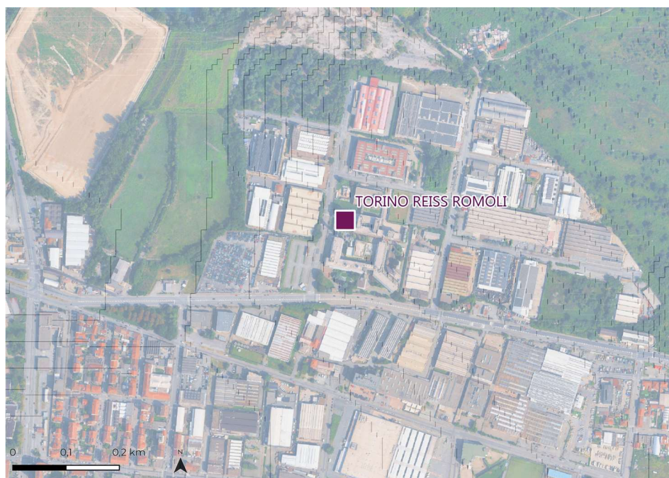
Figura 11 - Stazione di Torino Reiss Romoli su base ortofoto Google (2026)
