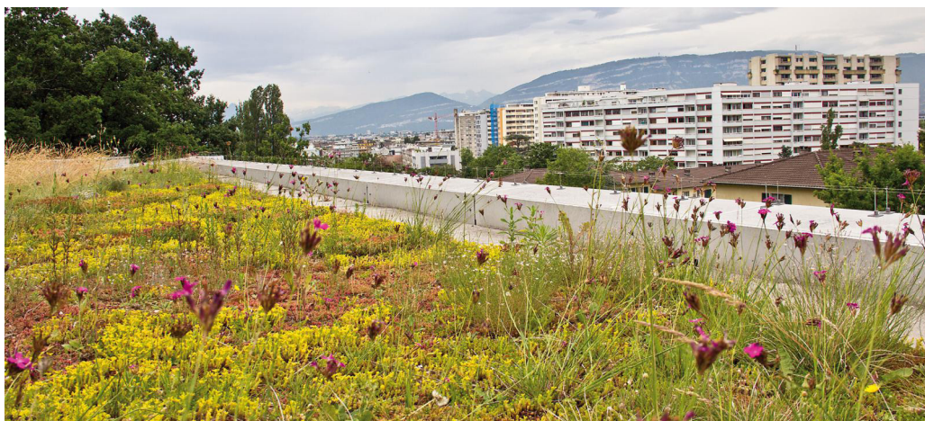
Fig.18 Tetto verde estensivo. Fonte: zinco-italia.it
