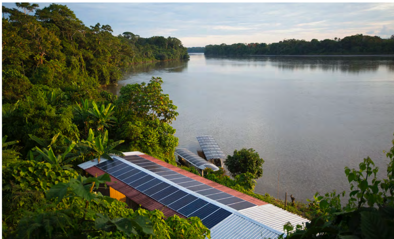
Figura 4.2: I centri solari possono essere usati per ricaricare le barche solari oltre a fornire energia per l'illuminazione e internet nei villaggi remoti. Fonte: Fundación Kara Solar
