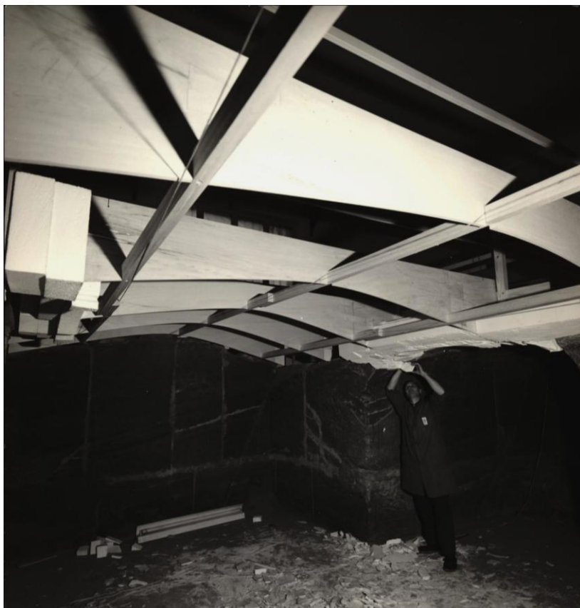
Fig. 3.6_10 I tecnici della Pininfarina durante la preparazione dei modelli delle volte. La copertura è stata poi realizzata in lamiera di lega leggera presso l'officina del Centro Studi Pininfarina. (VOLPIANO, 1970)
