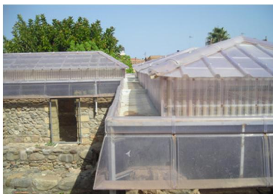
Figura 153 – Villa romana di San Biagio a Terme Vigliatore. Copertura progettata da Franco Minissi (foto F. Pintaudi, 2011) Roman Villa di San Biagio at Terme Vigliatore. Existing shelter designed by Franco Minissi (foto F. Pintaudi, 2011).
