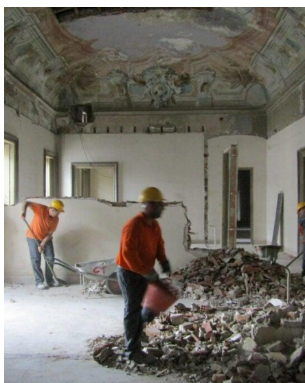
Figura 108 – Giovanni Cappelletti, Progetto e Cantiere per l'allestimento di Palazzo Butera a Palermo .
