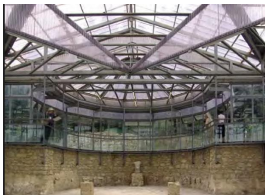
Figura 149 – La grande sala triloba con vista delle passerelle sovrastanti da cui è possibile osservare i mosaici pavimentali raffiguranti il trionfo di Ercole. Le passerelle sono ancorate tramite tubolari metallici alla muratura di sacrificio realizzata sopra ai resti delle strutture murarie antiche. (Foto B. Vivio 2005).
