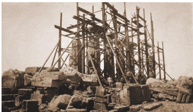
Figura 165 – Veduta del cantiere da Nord con le colonne rialzate.
