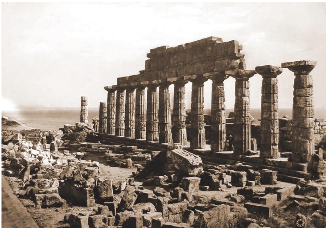
Figura 167 – Il Tempio C a lavori ultimati: Nella veduta da nord-ovest. Si notano le integrazioni in mattoni di laterizio con finitura ad intonaco.
