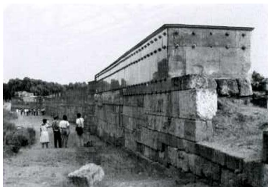
Figura 181 – Gela, mura greche di Capo Soprano, vista della fronte interna dell'fortificazione in una foto del 1985, dopo l'eliminazione della copertura progettata da Minissi.
