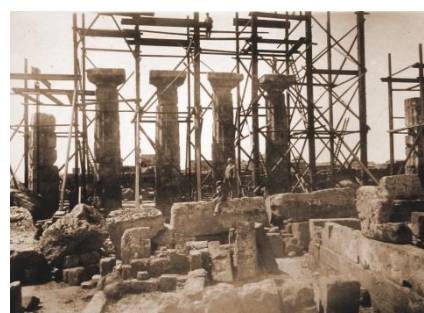
Figura 164 – Vedute del cantiere da nord con le colonne 6, 9, 10, 11, 12 e 13 rialzate.
