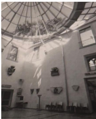
Figura 171 – L'Aquila, complesso di S. Maria dei Raccomandati (F. Minissi, 1993), copertura in vetro della corte. (da B. Vivio, 2006).
