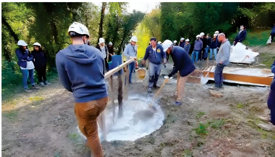
Figura 119 – Archeologia sperimentale a Bagni di Petrolo: docenti e studenti dell'Università degli Studi di Firenze e di Siena, supervisionati dagli operatori del cantiere di restauro, alle prese con la produzione della malta attraverso modalità di lavorazione usate nel Medioevo. (Fotografia di G. Fenili).
