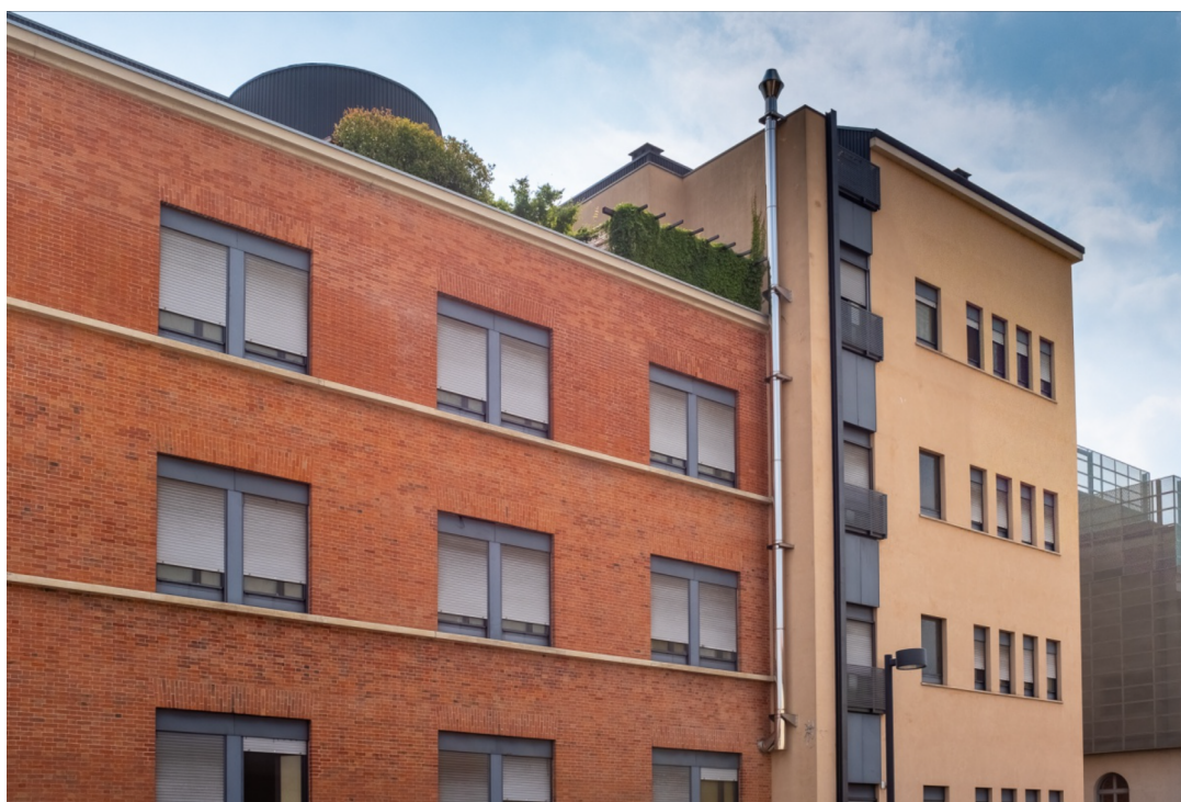
Figura 4.4: L'Ospiteria dell'Arsenale si trova in via Vittorio Andreis 18/27. E' strettamente interconnessa alle dinamiche dei locali principali ed è la struttura deputata nello specifico alle attività di accoglienza residenziale, che rappresentano una delle direttrici storiche del SERMIG. Le aree dell'edificio dedicate all'Accoglienza e all'Ospitalità sono concepite per offrire un riparo immediato a chi si trova in condizioni di marginalità o di emergenza. Questi spazi non sono intesi come un semplice dormitorio, ma come veri e propri nodi di sussistenza e ripartenza. Fonte: elaborazione dell'autrice. Fonte: Google Earth.
