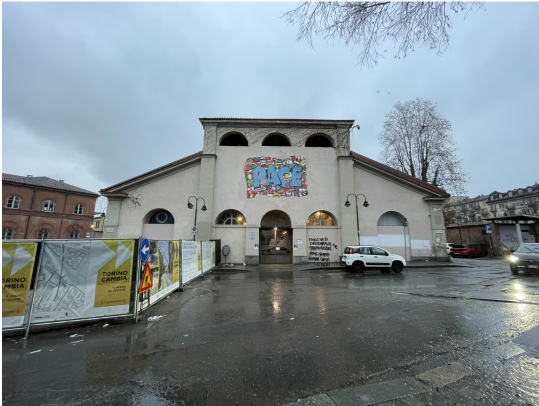
Figura 4.2: I locali dell'Arsenale della Pace si trovano in Piazza Borgo Dora 61 e costituiscono il fulcro nevralgico e operativo dell'intero complesso. L'edificio è stato trasformato nel corso dei decenni da antica fabbrica di armamenti a polo globale di pace e solidarietà. L'Arsenale non si configura come una singola struttura chiusa, bensì come un macro-contenitore permeabile che aggrega al proprio interno una pluralità di destinazioni d'uso e servizi specialistici. Fonte: foto dell'autrice.
