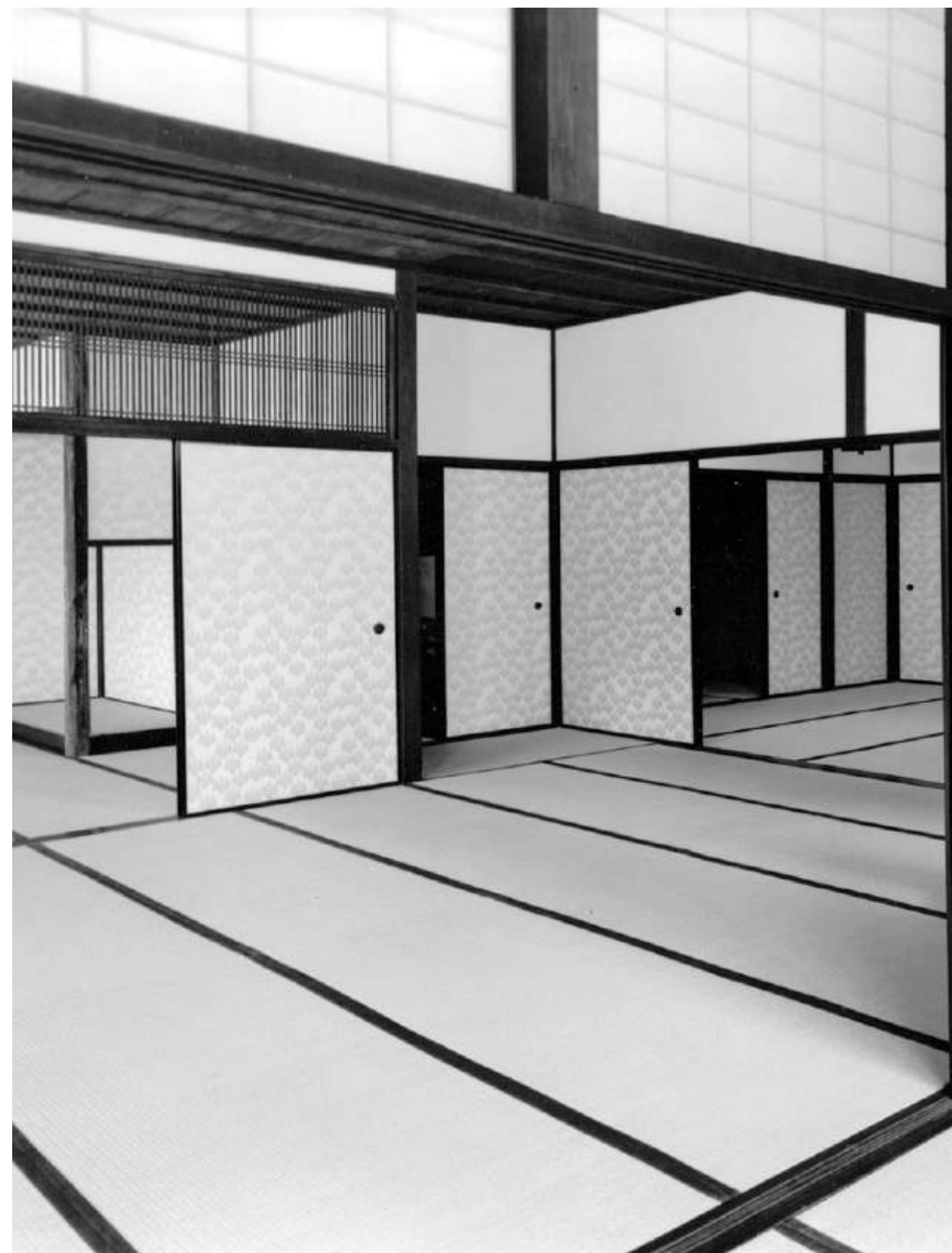
Interno della Villa Imperiale di Katsura, Kyoto. XVII secolo. Rigorosa modularità geometrica data dalla disposizione dei tatami e l'uso flessibile delle pareti scorrevoli. Fonte: Hidden Architecture
