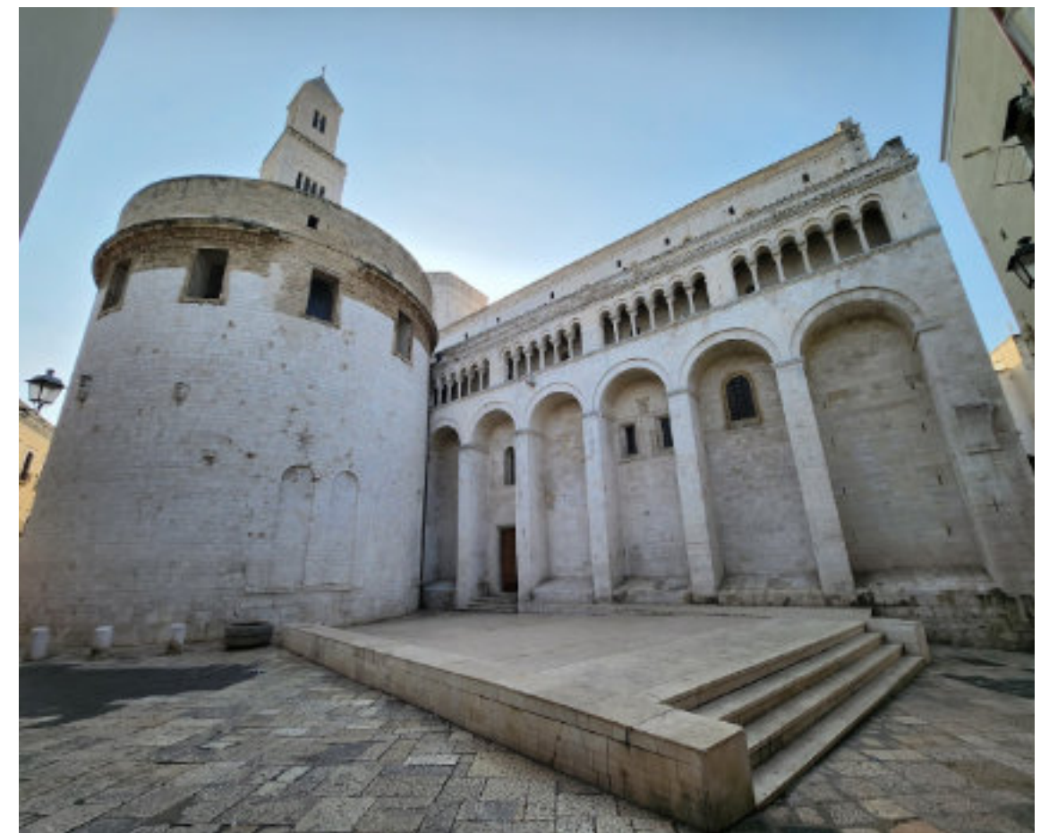
Fig.69 Cattedrale di San Sabino facciata laterale
