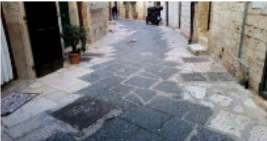
Fig.62 Pavimentazione in basalto
