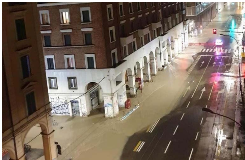
fig. 20: Via Saffi allagata a seguito dello scoppio del solaio al civico 22. 3 maggio 2023
