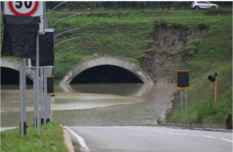
fig. 23: Sottopasso di viale Sabena inondato, 20 ottobre 2024
