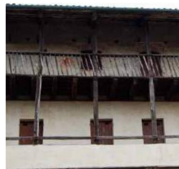
Castello di ponente, fronte est, loggiato ligneo con elementi verticali di supporto e parapetti , Lagnasco, 2025.
