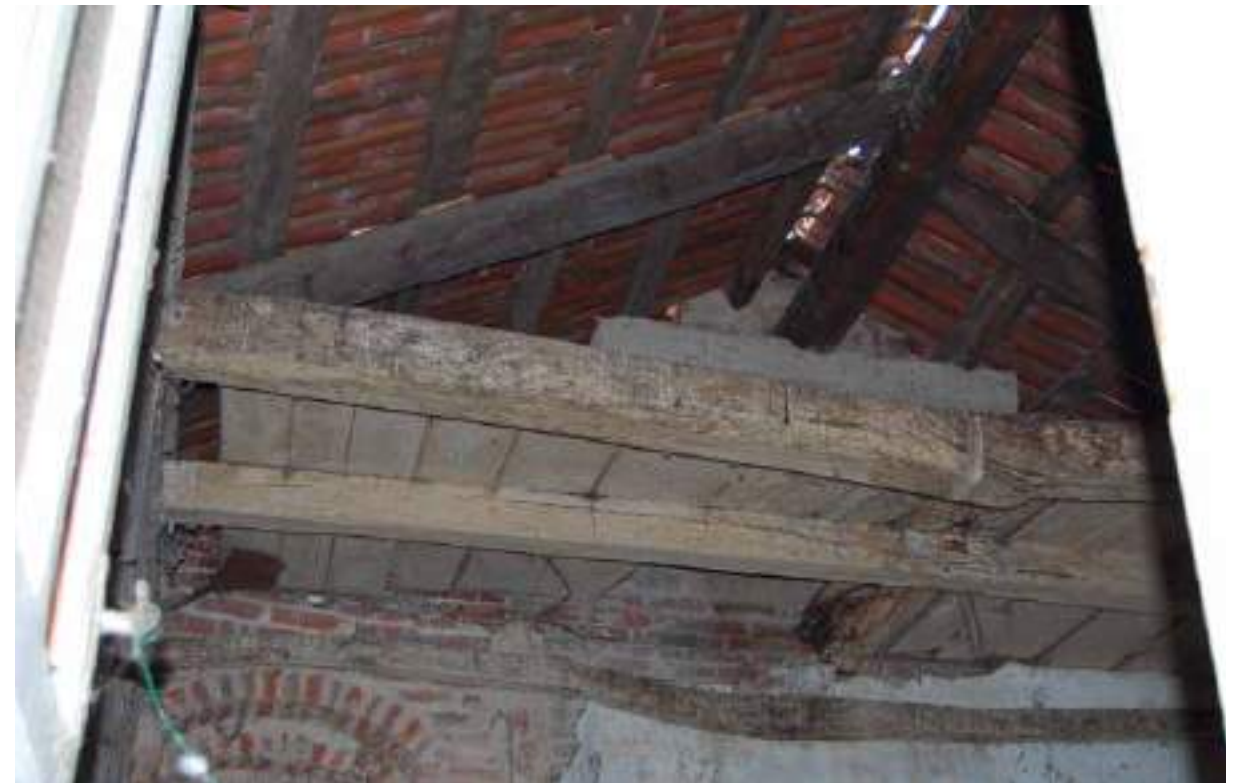
Fig. 70: Ultimo piano della testata meridionale del castello di mezzo, Lagnasco, 2025.
