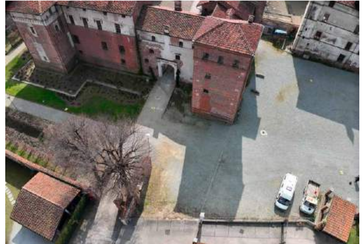
Fig. 36: ROGGERO M., Vista aerea del fronte nord di accesso mediante l'utilizzo di drone, Lagnasco, 2024.
