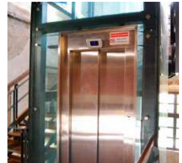
Castello di levante, vano ascensore con scatola strutturale in acciaio e vetro per garantire l'accessibilità ai piani superiori, Lagnasco, 2025.
