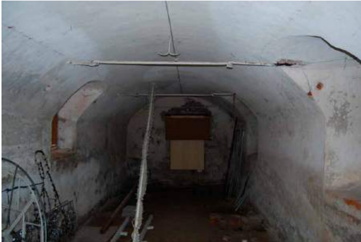
Fig. 50: Stanza non utilizzata e priva di pavimentazione della manica est di levante, Lagnasco, 2025.
