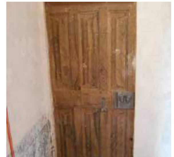
Castello di ponente, porta lignea con alterazioni superficiali e usura della finitura, Lagnasco, 2025.
