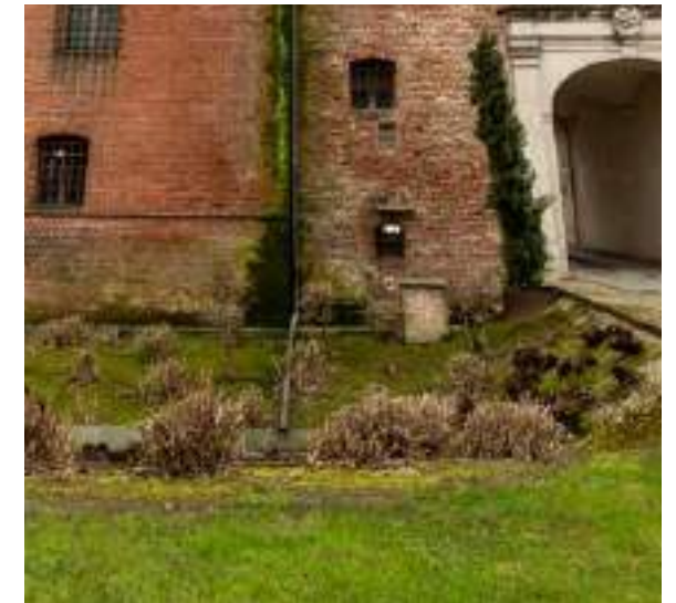
Castello di levante, fronte nord, zona verde relativa all'area di sedime dell'antico fossato, Lagnasco, 2025.
