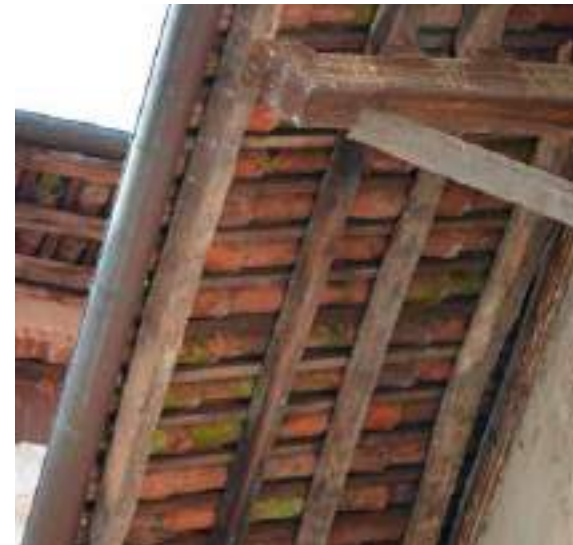
Castello di levante, fronte nord, sottostruttura lignea a sostegno del manto di copertura, con puntoni, orditura secondaria e orditura terziaria, Lagnasco, 2025.
