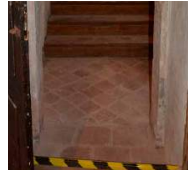
Castello di mezzo, pavimentazione in cotto a tessitura diagonale, visibile attraverso un varco tra due ambienti, Lagnasco, 2025.
