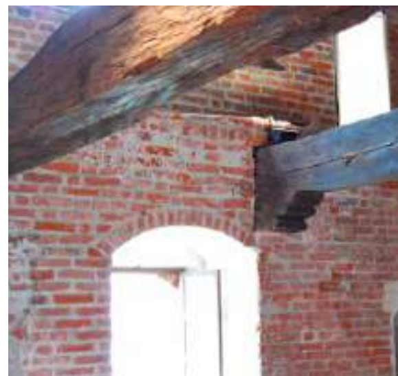
Castello di levante, muratura in laterizio a vista , recentemente restaurata, Lagnasco, 2025.
