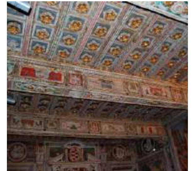
Castello di ponente, soffitto a cassettoni lignei intagliati e dorati, con rosoni in foglia d'oro su fondo azzurro-grigio e fregio sottostante dipinto con stemmi araldici e figure, Lagnasco, 2025.
