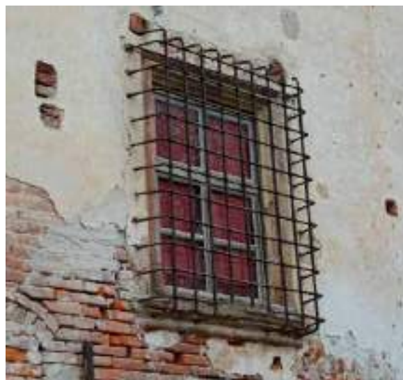
Castello di mezzo, fronte est, sistema di grate in ferro a protezione dell'infisso in legno
