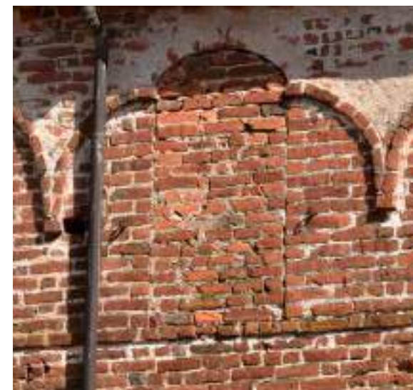
Castello di mezzo, fronte ovest, tamponamento sulla muratura perimetrale in laterizio , Lagnasco, 2025.
