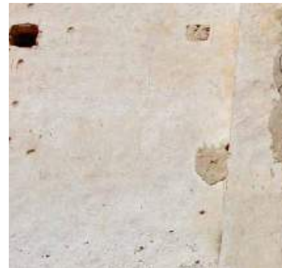
Castello di mezzo, fronte est, rivestimento superficiale in intonaco a base di malta , Lagnasco, 2025.
