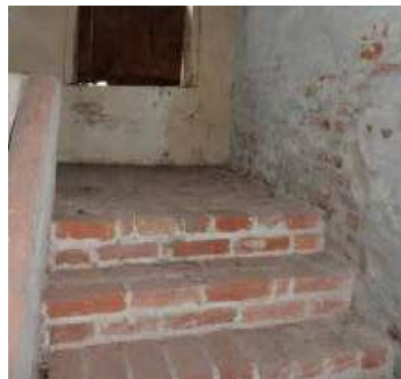
Castello di mezzo, scala in laterizio a vista tipica degli ambienti di servizio, Lagnasco, 2025.
