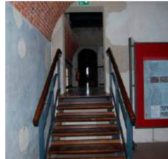
Castello di Levante, nuovo vano scala in acciaio con gradini rivestiti in legno, realizzato negli interventi di adeguamento più recenti, Lagnasco, 2025.
