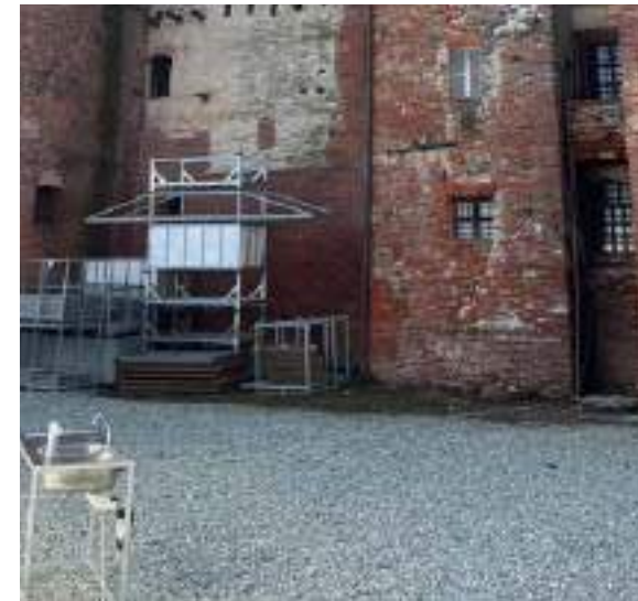
Piazza di pertinenza dei Castelli, pavimentazione in ghiaia di granulometria elevata , Lagnasco, 2025.
