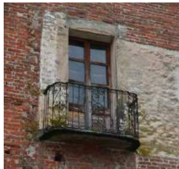
Castello di levante, fronte sulla corte interna, sistema di balconi in pietra con parapetti in ferro battuto , Lagnasco, 2025.
