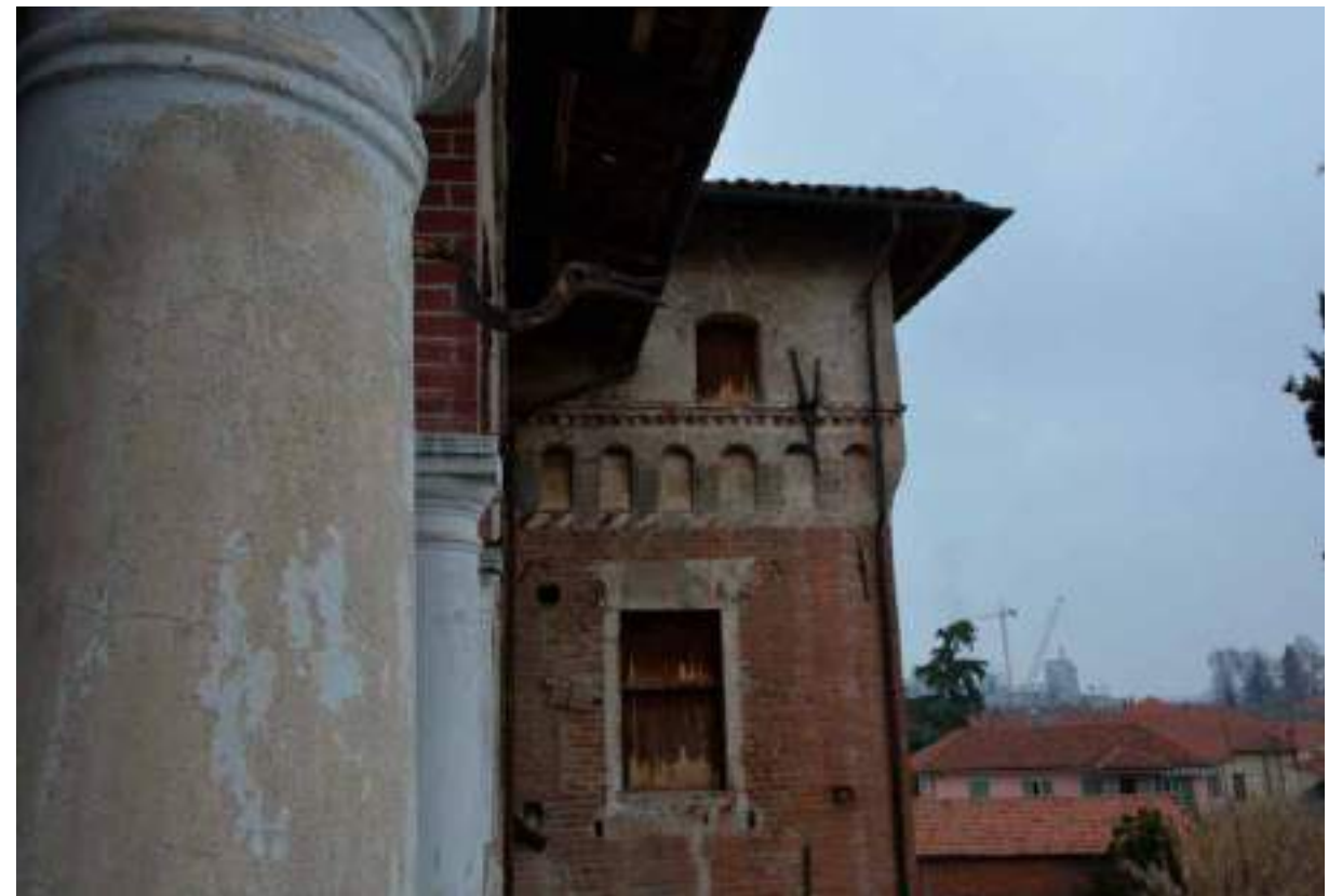
Fig. 69: Foto del loggiato al secondo piano del castello di levante, Lagnasco, 2025.
