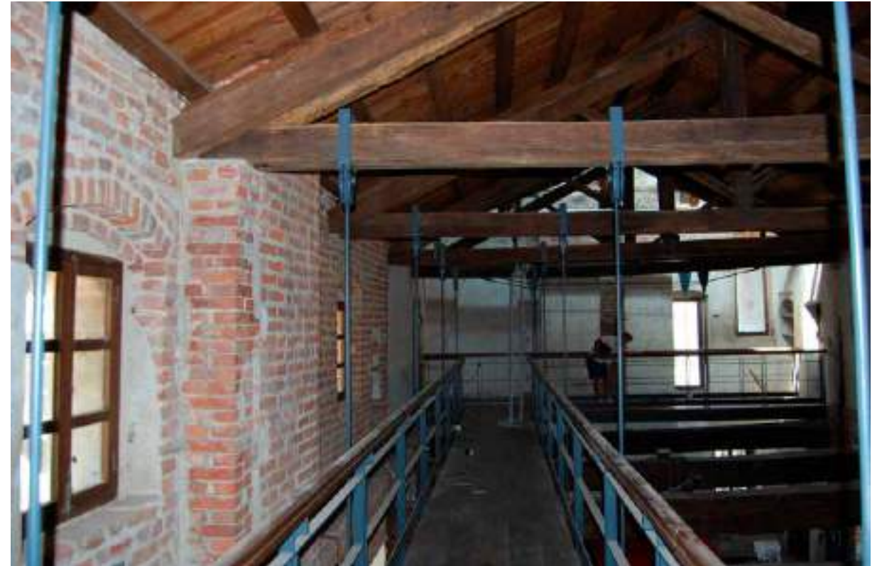
Fig. 68: Foto della passerella realizzata durante sopra la sala riunioni, intervento di restauro condotto da G. Gritella, Lagnasco, 2025.
