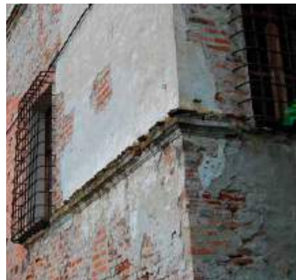
Castello di Ponente, fasce marcapiano in pietra , Lagnasco, 2025.
