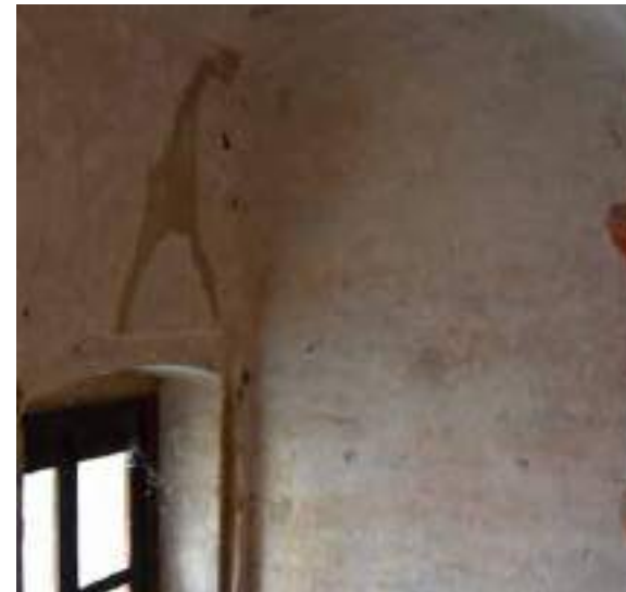
Castello di mezzo, intonaco a calce liscio e tinteggiato , Lagnasco, 2025.
