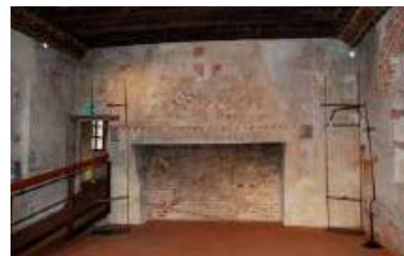
Fig. 78: Foto della rampa d'accesso al vano ascensore nel castello di ponente. Foto dell'autore, Lagnasco, 2025.
