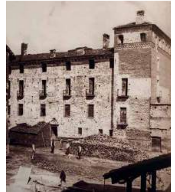
Fig. 31: MARINONI G., Lagnasco, il cortile centrale durante i lavori di restauro, 1867. Stampa all'albumina, in GRITELLA G., Il rosso e l'argento , cit., p. 301.
