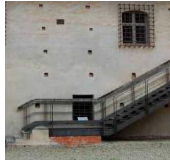
Castello di ponente, fronte est, scala di sicurezza in acciaio , realizzata durante i restauri di Gritella per la conclusione dell'itinerario museale, Lagnasco, 2025.
