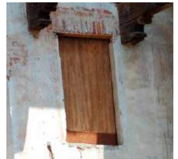
Castello di levante, fronte sulla corte interna, tampornamento in legno sulla tessitura muraria, Lagnasco, 2025.
