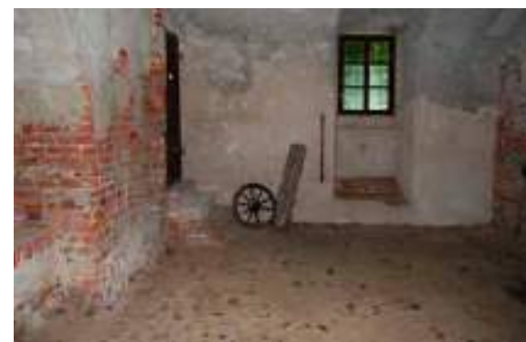
Fig. 72: Foto di scale interne tra i vari ambienti del castello di ponente. Foto dell'autore, Lagnasco, 2025.
