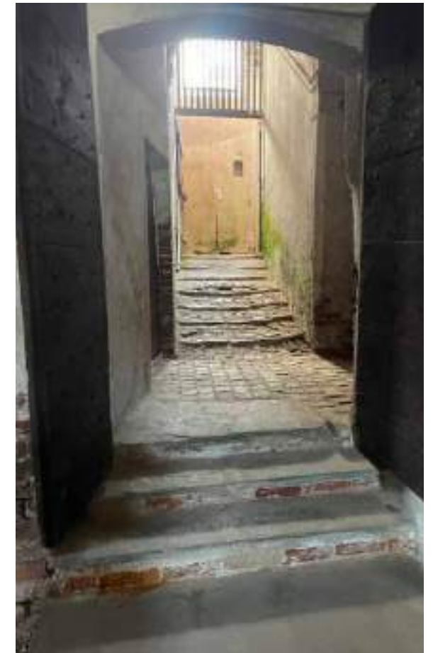
Fig. 73: Foto della scala di accesso del castello di ponente. Foto dell'autore, Lagnasco, 2025
