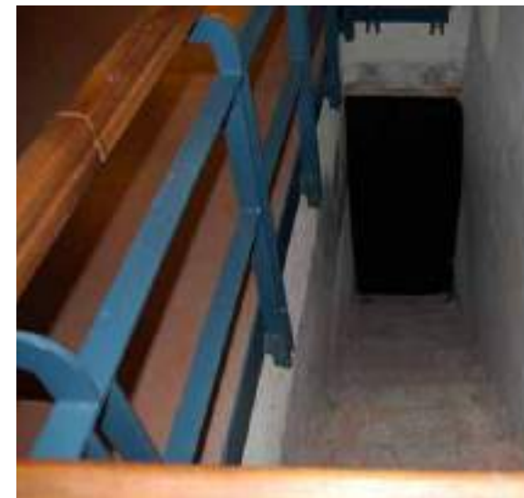
Castello di levante, parapetto tubolare in acciaio verniciato blu, inserito come presidio di sicurezza lungo una scala interna storica, Lagnasco, 2025.
