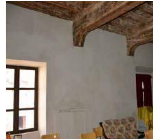
Castello di mezzo, intonaco a calce liscio non tinteggiato , Lagnasco, 2025.
