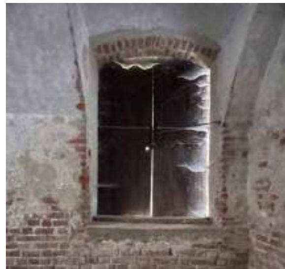
Castello di mezzo, serramento ligneo a scuretti interni inserito in un'imbotte in laterizio con un elemento metallico passante, Lagnasco, 2025.
