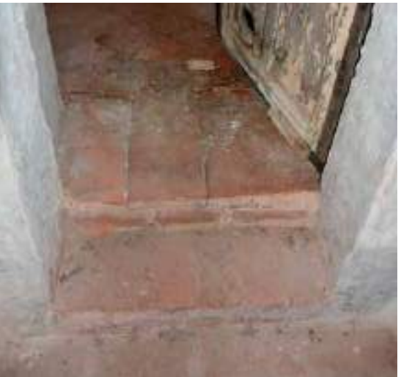
Castello di mezzo, scheggiatura e usura degli spigoli e usura da calpestio in prossimità delle soglie , Lagnasco, 2025
