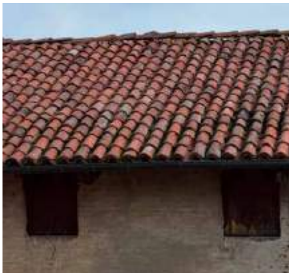
Castello di mezzo, manto di copertura in coppi di canale e coperta , Lagnasco, 2025.
