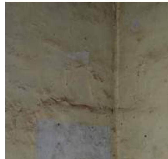
Castello di ponente, esfoliazione degli strati di tinteggiatura , Lagnasco, 2025.
