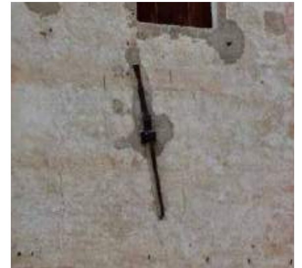
Castello di mezzo, fronte est, "chiavi belliche" utilizzate, nel corso dei restauri, per il consolidamento delle murature storiche attraverso catene interne, Lagnasco, 2025.
