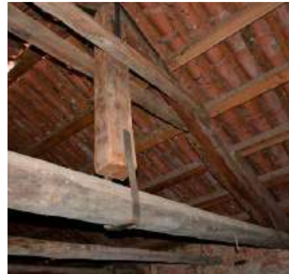
Castello di mezzo, struttura di copertura lignea a vista, con travi principali e travetti secondari a sostegno del manto in coppi di laterizio, in un ambiente di sottotetto privo di finitura, Lagnasco, 2025.
