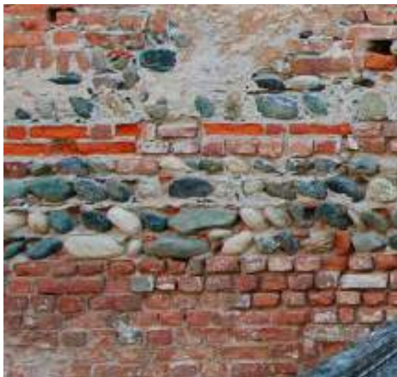
Castello di levante, fronte ovest, tessitura muraria in ciottoli di fiume listata con fasce orizzontali in laterizio, Lagnasco, 2025.
