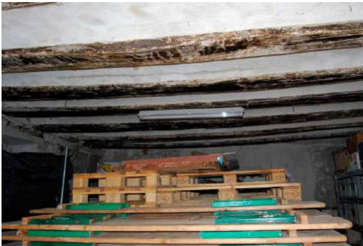
Fig. 47: Magazzino della Pro Loco nel corpo sud del castello di mezzo, Lagnasco, 2025.
