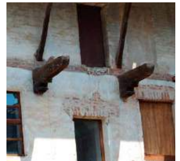
Castello di mezzo, fronte sud, travi e mensole lignee a supporto loggiati, oggi demoliti, Lagnasco, 2025.
