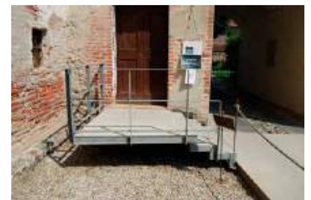
Fig. 75: Foto delle scale esterne per l'accesso alla biglietteria dei castelli. Foto dell'autore, Lagnasco, 2025.
