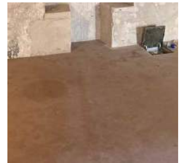
Castello di mezzo, pavimentazione in resina realizzata priva di giunti, Lagnasco, 2025
