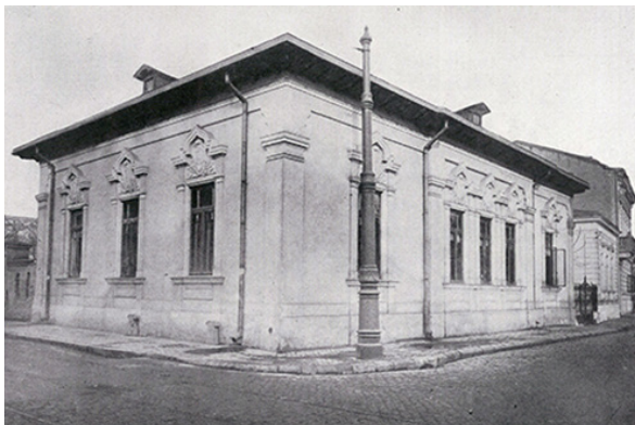
Figura 60 - Casa Ion Mincu nel suo stato originario - https://oar.archi/buna-practica/conservare-nu-muzeifica-re-casa-mincu-bucuresti/
