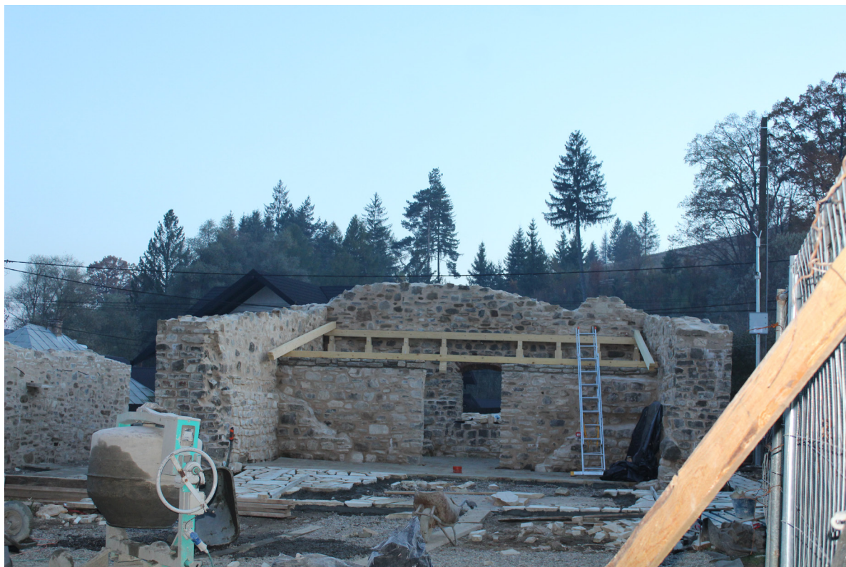
Figura 128 - Lavori del cantiere ancora in corso per il restauro dei resti del monastero di HUmor, fotografia dell'autore scattata ad Ottobre 2025.
