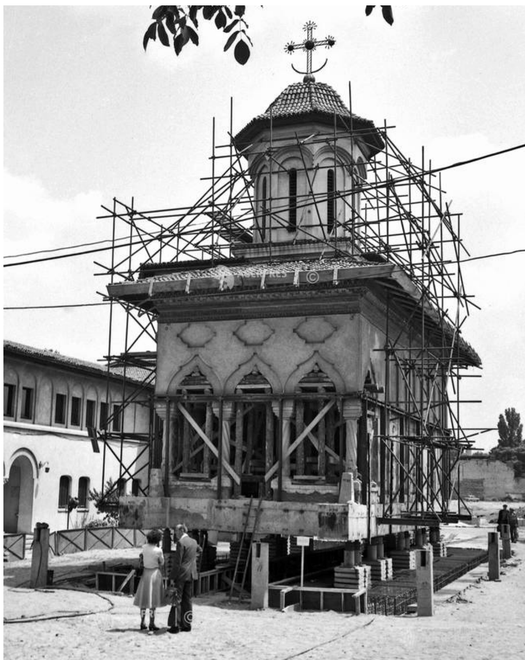
Figura 51 - Schitul Maicilor durante i lavori di traslazione dell'edificio. Fotografia di Armand Rosenthal del 1982, in https://foto.agerpres.ro/ro/mutare-a-bisericii-schitul-maicilor-bucuresti-1982/803349 .
