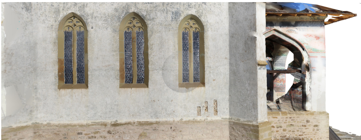
Figura 153 - Vista dal lato orientale della chiesa di Sucevița che mostra i dettagli di serramenti ma anche i degradi. Elaborato estrapolato dal 3D realizzato dall'autore con l'aiuto del software Agisfot Metashape attraverso il processo di fotogrammetria.
