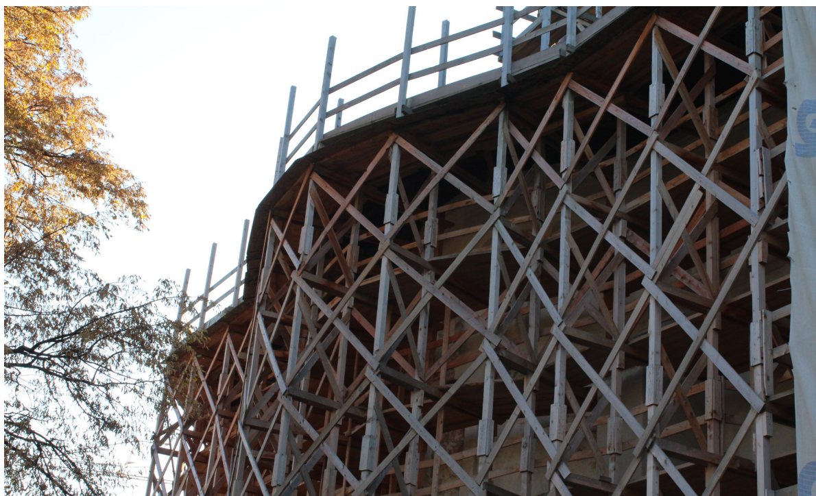
Figura 116 - Lavori di consolidamento alla chiesa, fotografia scattata dall'autore nell'Ottobre 2025.
