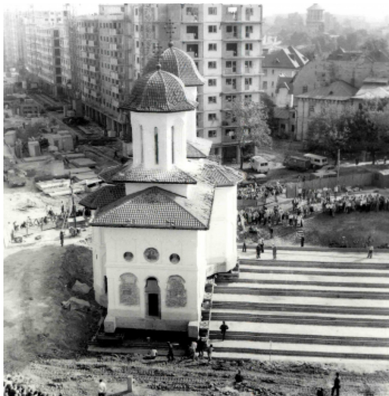
I lavori di traslazione di un edificio a Bucarest, https://www.icr.ro/praga/din-istoria-recenta-a-tehnicii-romanesti-metoda-ing-dr-eugeniu-iordachescu-de-translare-a-monumentelor-istorice-26677
