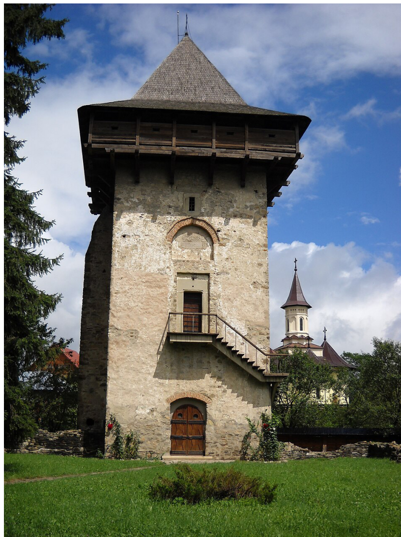
Figura 127 - Vista della torre del monastero con l'attuale scala fissa che collega il piano terra con il primo, https://encrypted-tbn0.gstatic.com/images?q=tbn:ANd9GcTgr5lld3bL5gOUziSHUxdk08B3UTwTRUuDR0Foi1HucaFuJC-GR-L_KIJK&s=10
