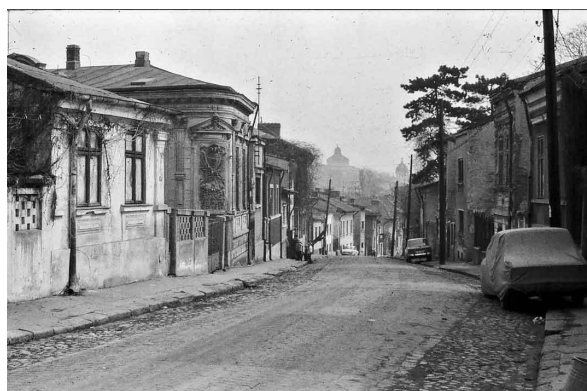
Figura 38 - Strada Ecoului del quartiere Uranus di Bucarest prima della demolizione, immagine risalente al 1984 di https://b365.ro/exclusiv-demolari-si-praf-apocaliptic-cum-a-fost-construit-bd-victoria-socialismului-azi-al-unirii-nestiuta-istorie-a-arterei-faraonice-a-lui-ceausescu-si-a-fai
