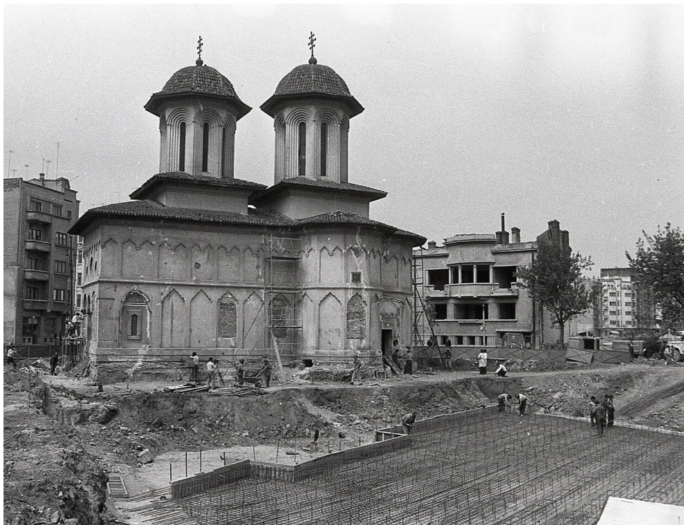
Figura 42 - Chiesa Olari nel 1982 durante le operazioni di spostamento - https://bucurestiulmeudrag.ro/fotografii/58cfd4a4-c93c-46cc-a0b2-8e77592b13d5
