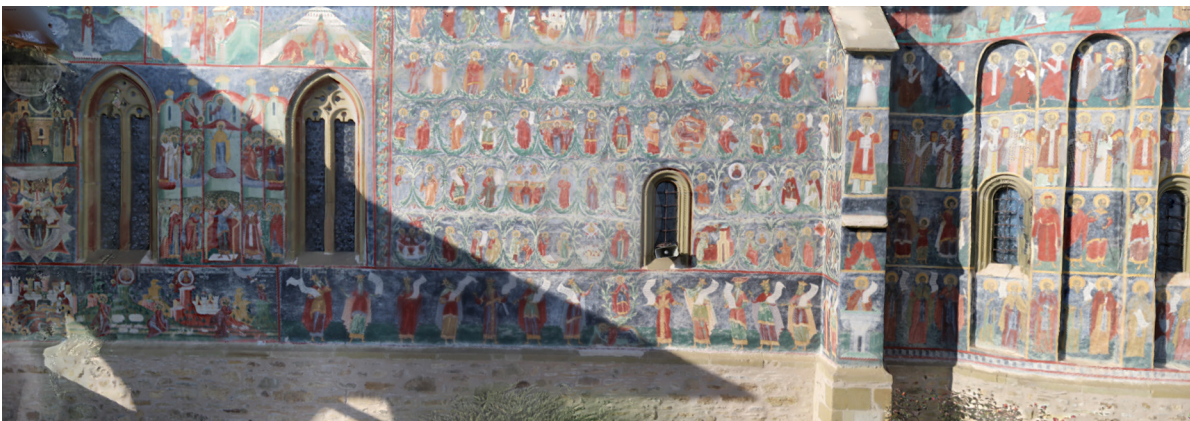
Figura 152 - Vista del lato Sud della chiesa di Sucevița che mostra i dettagli esterni. Elaborato estrapolato dal 3D realizzato dall'autore con l'aiuto del software Agisfot Metashape attraverso il processo di fotogrammetria.
