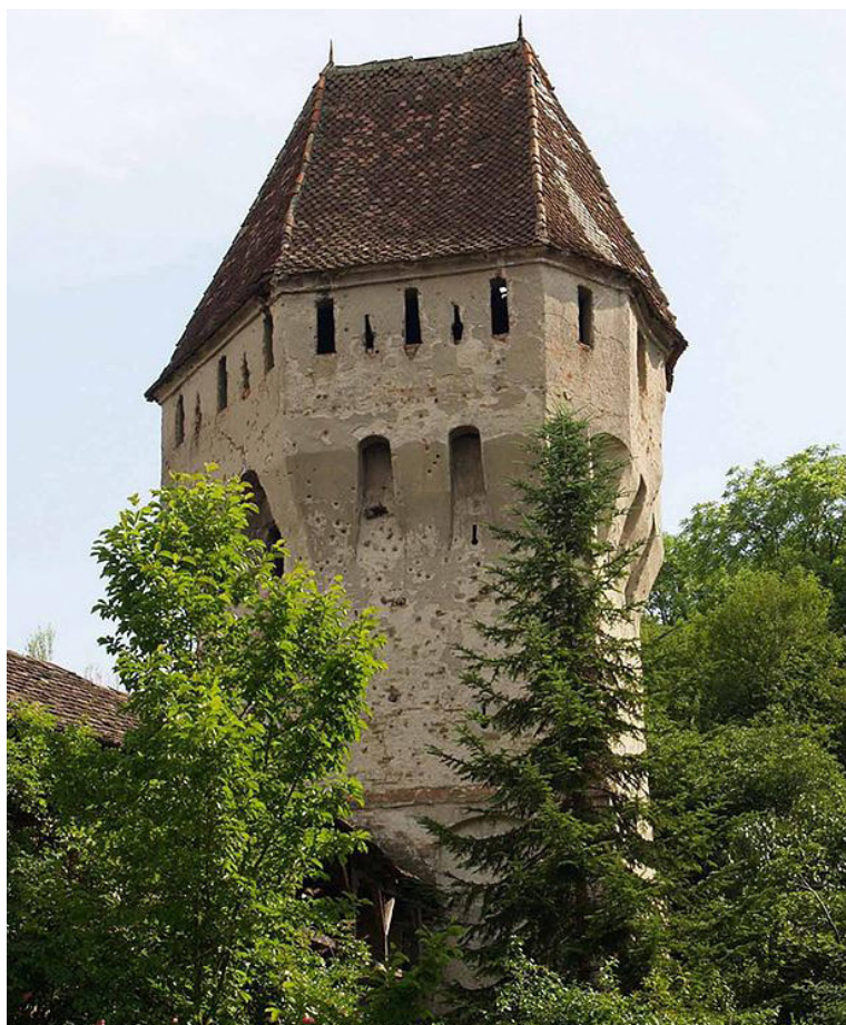
Figura 91 - Una delle torri ancora presenti della fortificazione della città, in https://patrimoni.ro/en/articles/centrul-istoric-sighisoara
