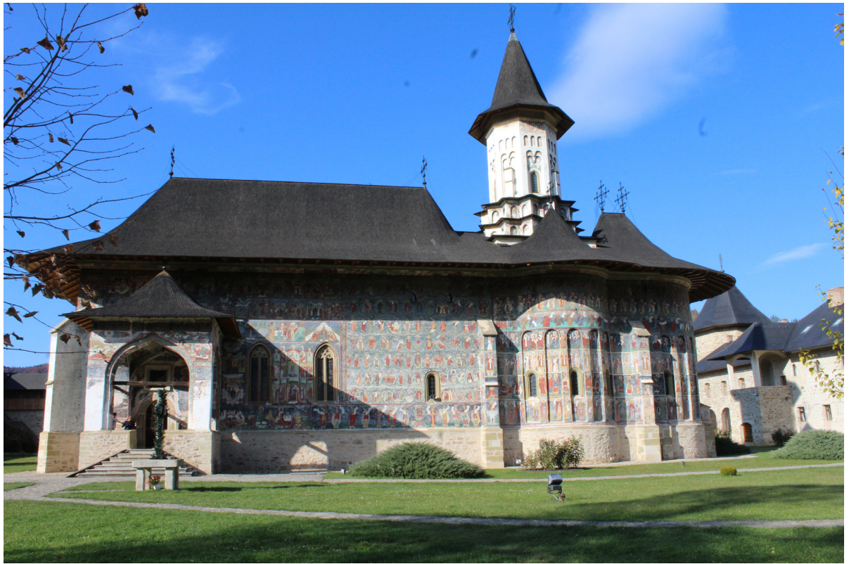
Figura 146 - Vista lato Sud della chiesa, fotografia dell'autore risalente ad Ottobre 2025.
