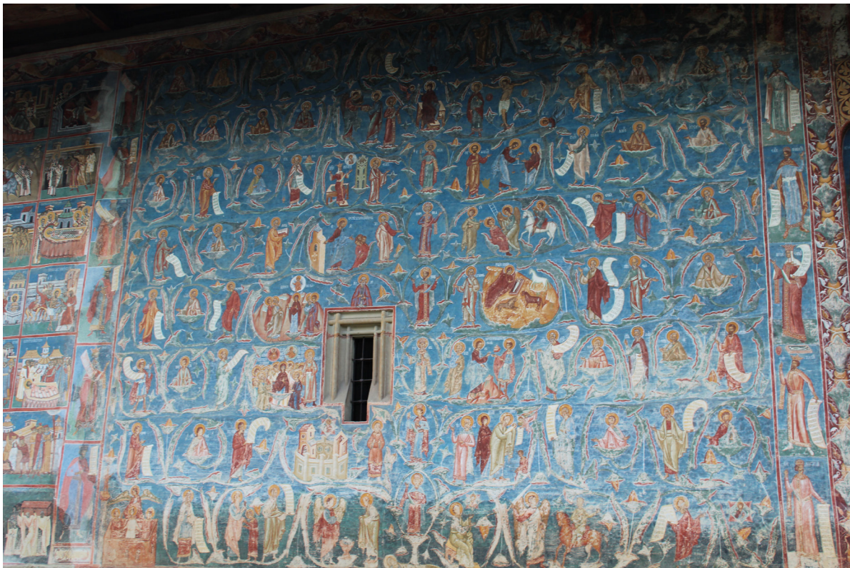
Figura 133 - Lato Sud esterno della chiesa, in cui è ben visibile l'azzurro caratterizzante dei dipinti originali, fotografia dell'autore risalente ad Ottobre 2025.
