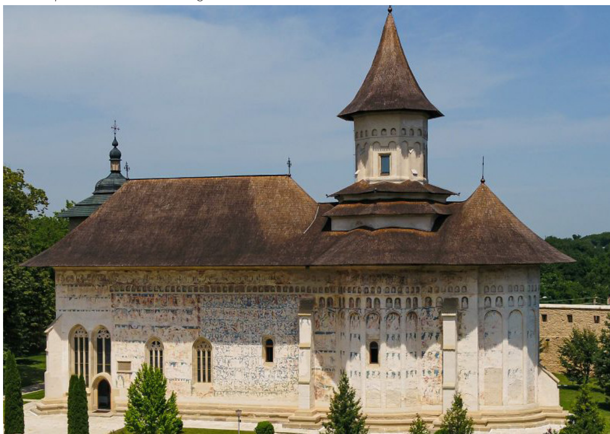
Figura 117 - Chiesa di probota vista dall'esterno, https://hecross.net/en/objects/monastyr-probota/
