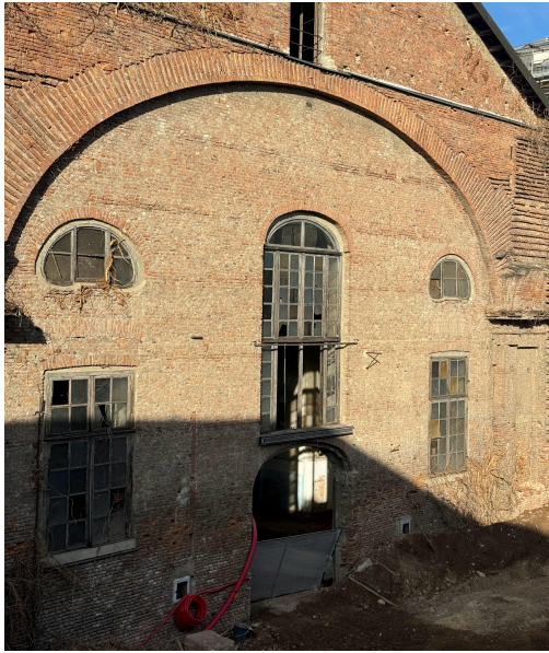
Figura 5. Fotografia dell'autrice 2026. Arcone della facciata del Maneggio della Cavallerizza Reale, esempio dell'elemento strutturale descritto nelle fonti archivistiche.
