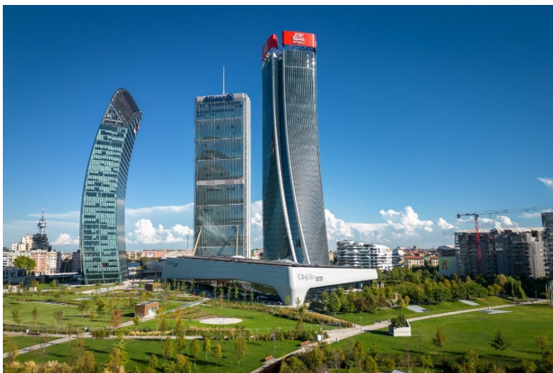
Figura 20. Vista del complesso di CityLife Direzionale; [ https://www.city-life.it ]
